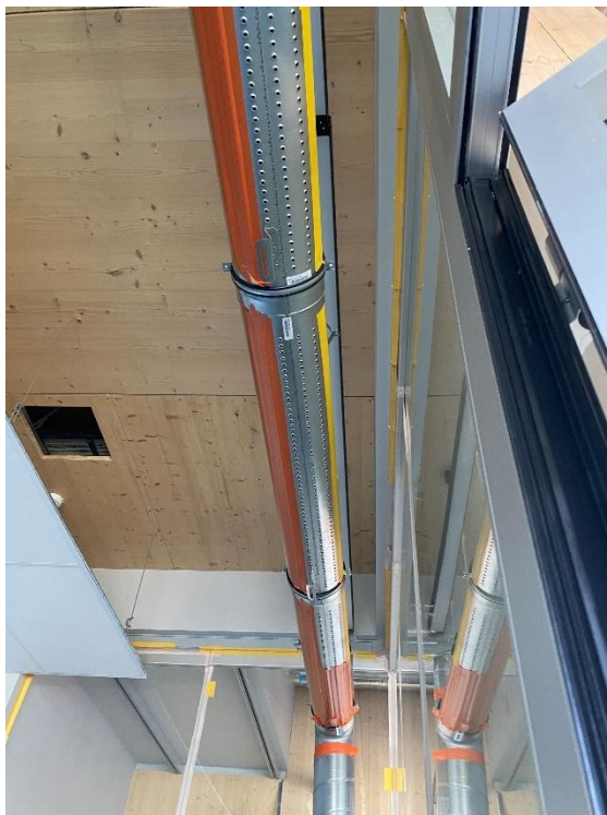
Joonis 6. 120° sektoriga düüstoru, millel on 6 düüsi rida.
