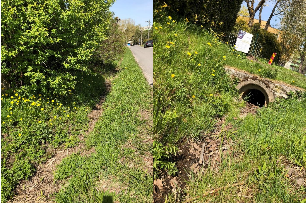
Pilt 4 Algi tänava sademeveekraav ja truup (autori fotod).
