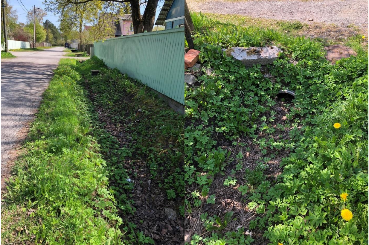
Pilt 3 Algi põigu sademeveekraav vasakul pildil ja üks süsteemi truupidest paremal pool (autori fotod).
