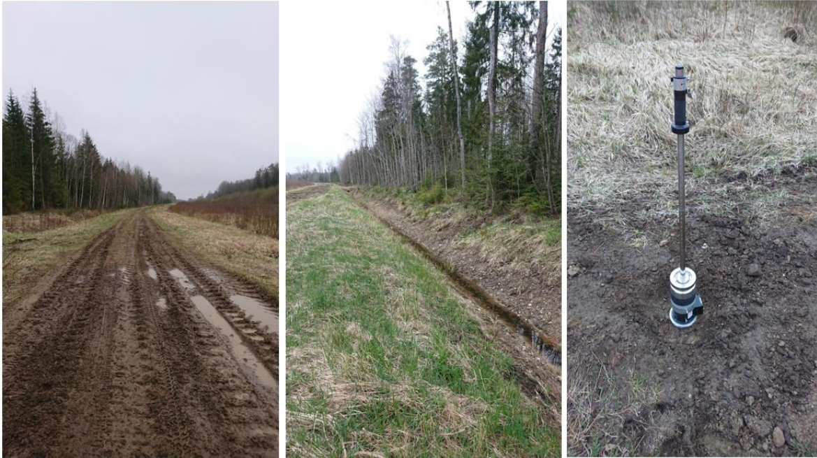
Joonis 5.3 Olemasolev pinnastee (vasakul), puhastatud kraavid (keskel), kandevõime mõõtmine Dynatest LWD'ga (paremal) [erakogu]
