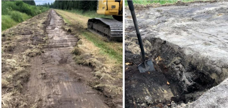
Joonis 5.10 Taimestikust läbikasvanud pealmise kihi koorimine peale mida jäi kohati alles vaid metsakõdu kiht [erakogu]
