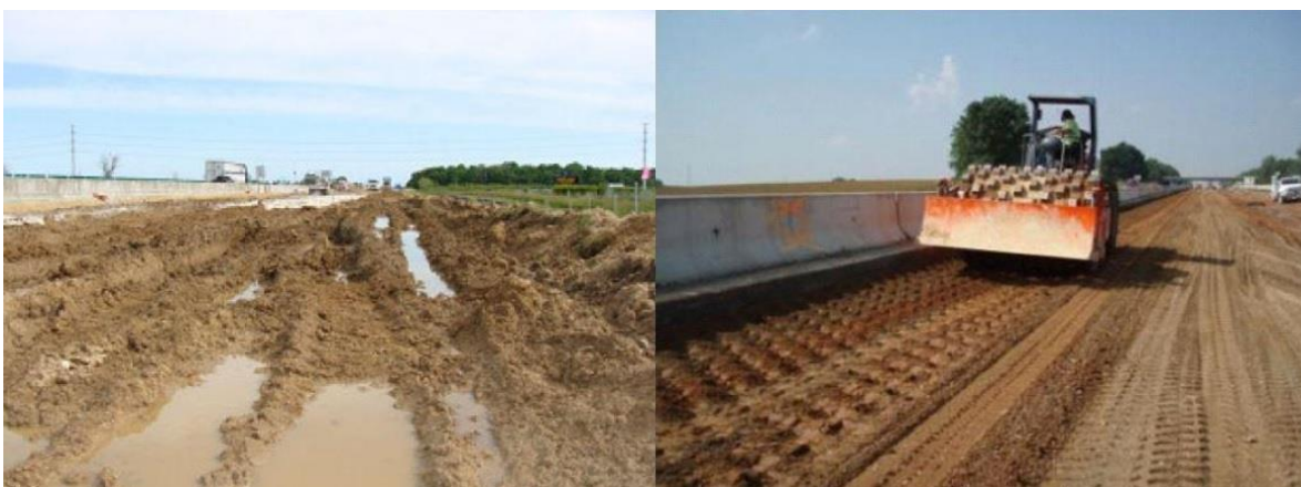
Joonis 4.2 Liigniiske pinnas (vasakul) ja lubjaga kuivatatud pinnas (paremal) [16]
