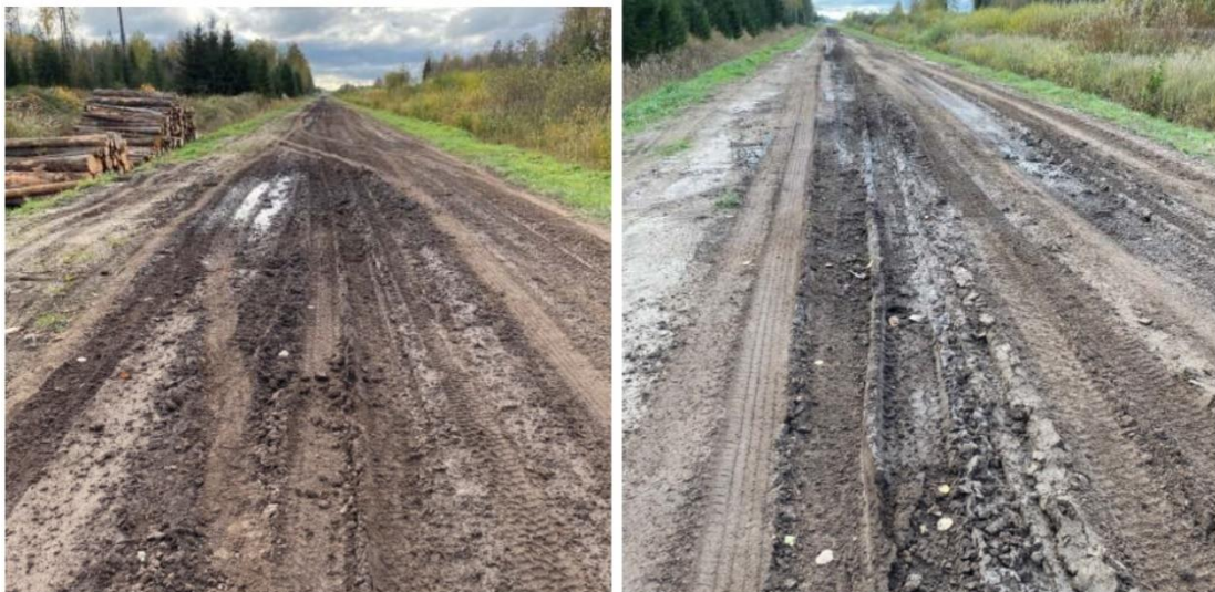
Joonis 5.22 Kohtades, kus on segusse sisse tulnud rohkem orgaanikat (metsakõdu), on vähemal või suuremal määral lagunened [erakogu]
