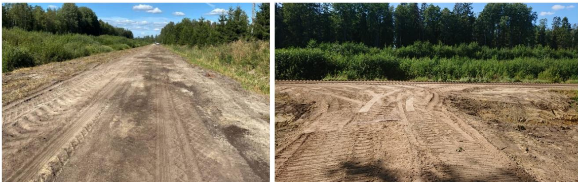
Joonis 5.16 murukaar on eemaldatud ja pind profileeritud (vasakul), kruusast tagasipöördekoht (paremal) [erakogu]
