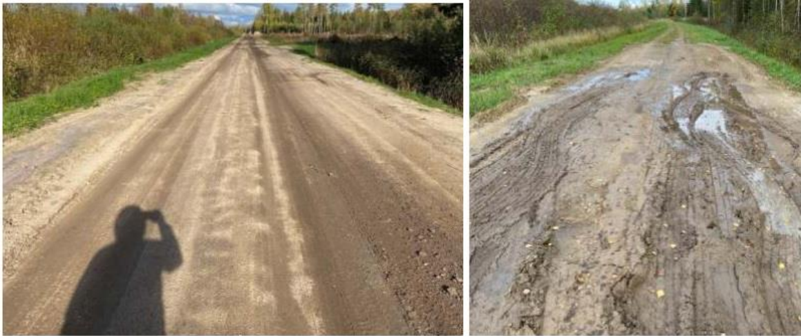
Joonis 5.21 Teelõigu alguses olev liivane osa on metsaveole hästi vastu pidanud (vasakul), teelõigu otsas on teekate muutunud ligaseks ja libedaks (paremal) [erakogu]
