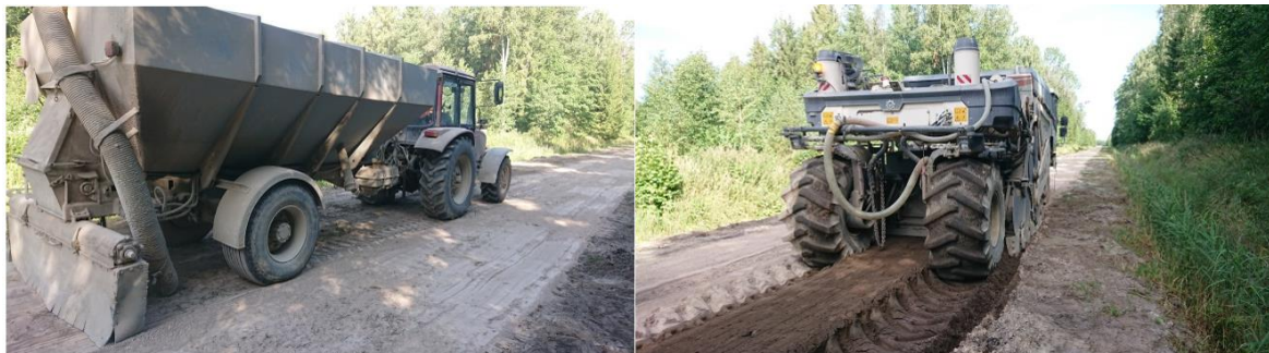
Joonis 5.17 Põlevkivituha laotamine tsemendilaoturiga (vasakul), stabiliseerimisfreesiga segamine (paremal) [erakogu]
