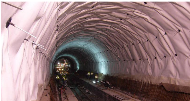
Joonis 33 . Veekindel geomembraan tunneli hüdroisoleerimiseks (Atarfil, 2019).
