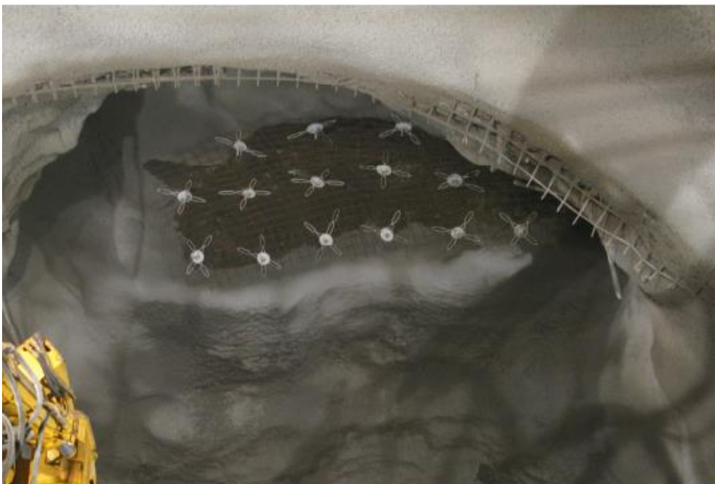
Joonis 37 . Rikke korral kasutatakse terasvõrku koos ankrutega (Hjálmarsson, 2011).
