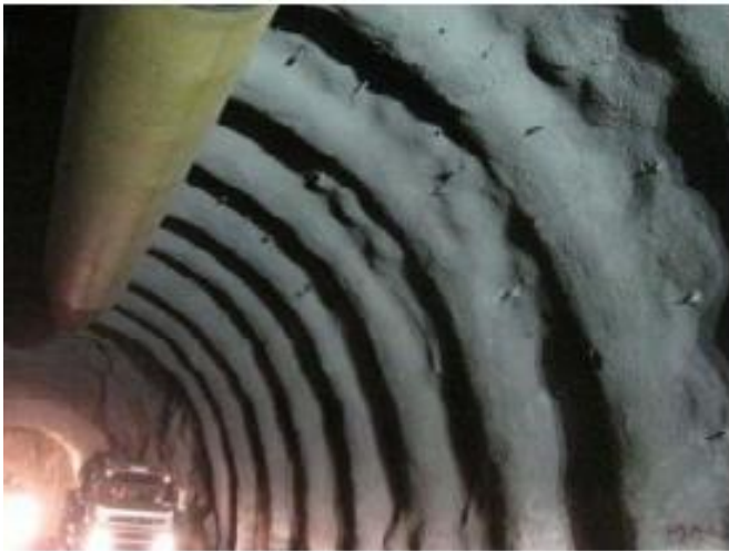
Joonis 14. Tri-armatuur paigaldatuna pritsbetooni alla (Jorimann, 2010)
