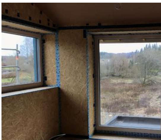
Joonis 3.4 Õhutõkkekihi liitekohtade teipimine
