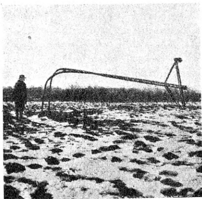
Joon. 6. Murdunud terasmast 35 kV elektriliinil Ungaris.
