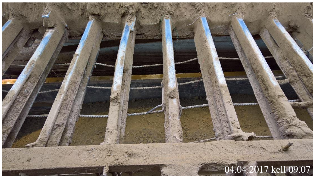
Joonis 7. Laadimisestakaadi rest, millele buldooserid põlevkivi lükkavad
