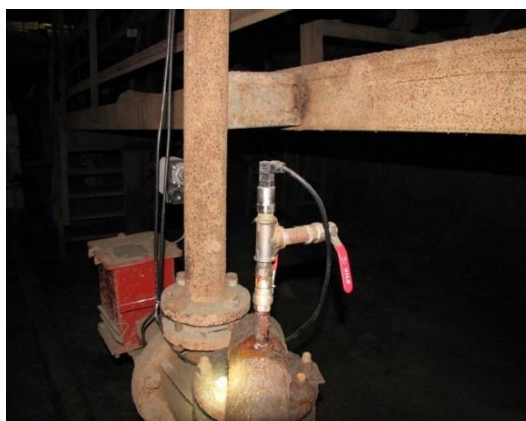
Рисунок 21. Датчик давления воды Comeco PSP. (Фото автора).
