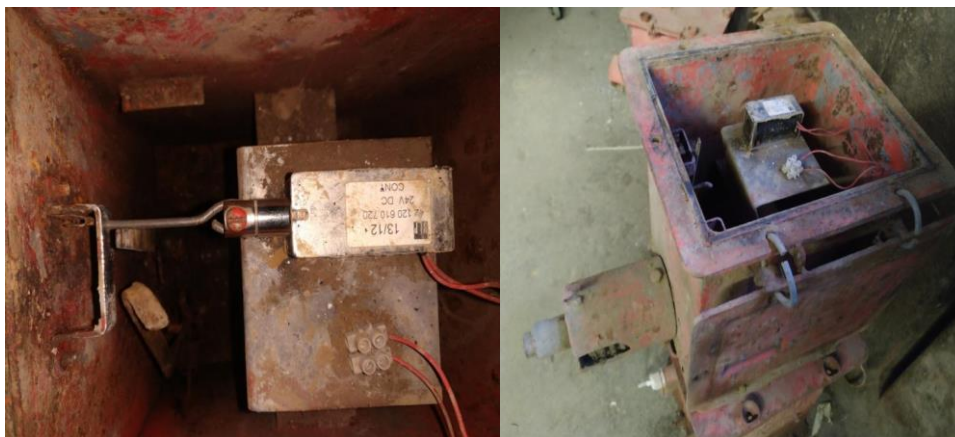
Рисунок 24.Клапан системы пожаротушения (Фото автора)
