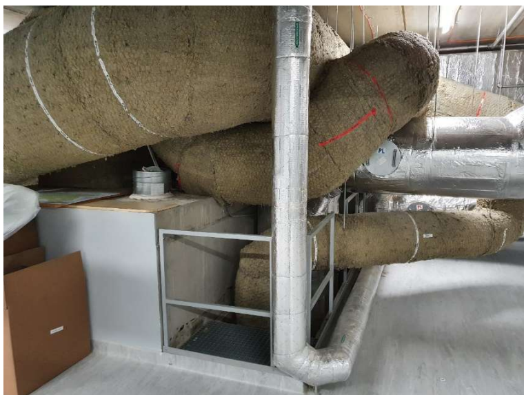
Pilt 25. Torn 2 15 korruse tehnoruum, liftišahti tuulutuse ots
