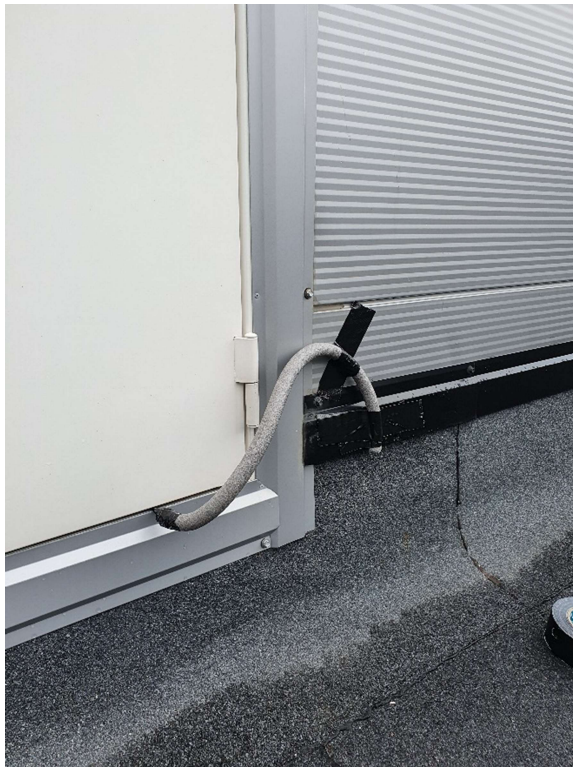
Pilt 17. Atmosfääri rõhu mõõtmistraat ukseavas VU : vasakul tehnoruumi poolt ja paremal katuse poolt (tuulest kaitsetorus sees).
