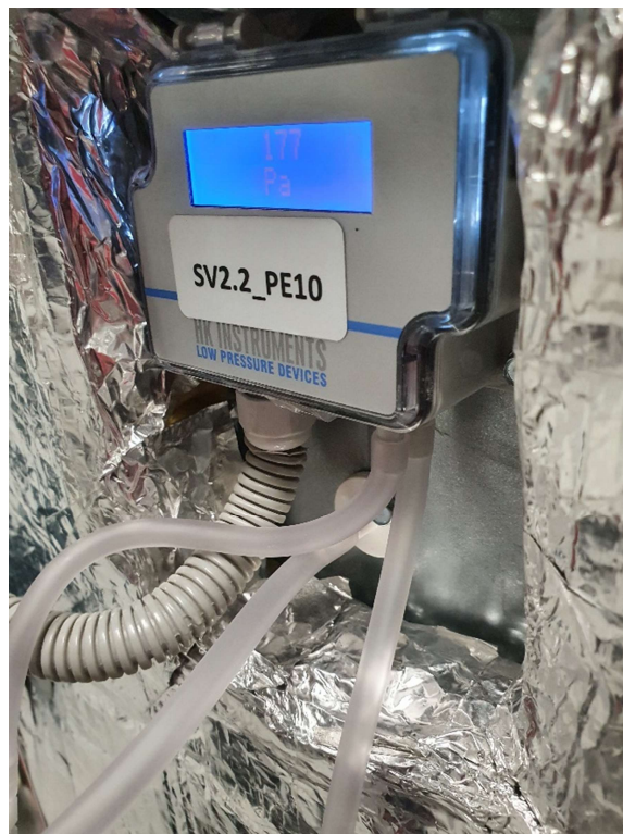
Pilt 16. Ventseadme SV2.2 sissepuhkeõhu staatilise õhurõhu mõõtmine (atmosfääri rõhu mõõtmine väliskeskkonnast)
