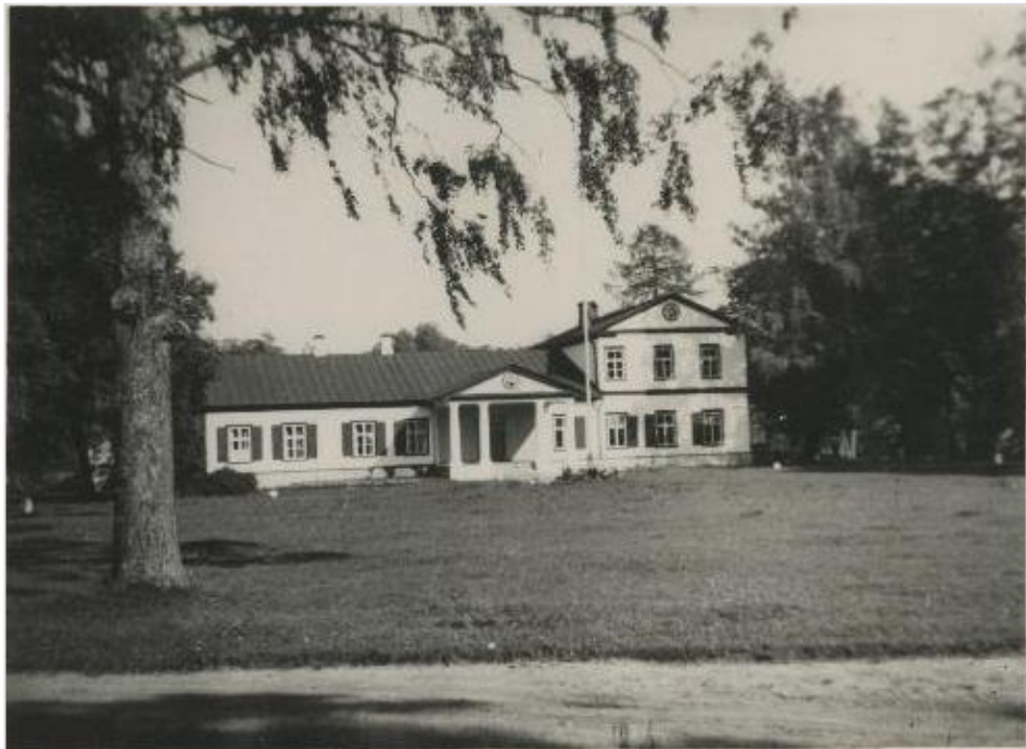
Joonis 10. Võhmuta mõisa peahoone fassaad. 01.01.1890 – 1919. EAA.4373.1.238.50.
