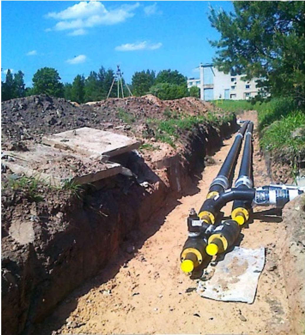
Joonis 3.2 Foto Paikuse soojusvõrgu rekonstrueerimisest [6]
