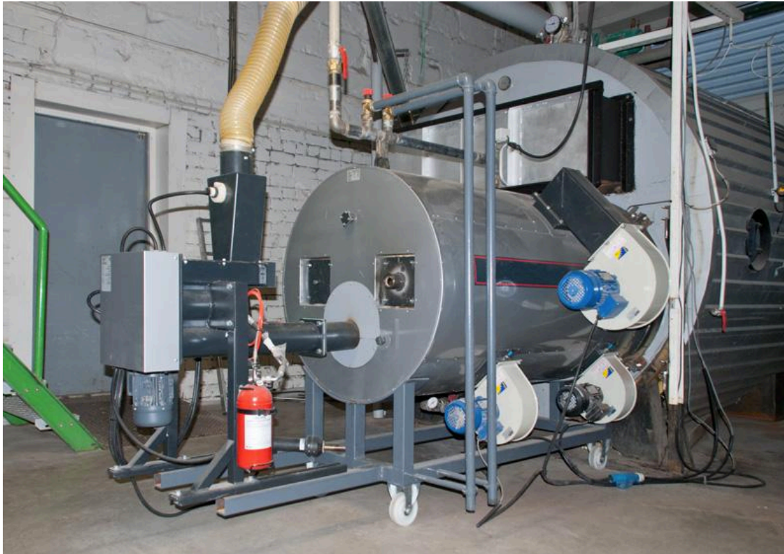
Joonis 3.4 Foto Kiviõli-80 katel + Armikas graanulipõleti 1 MW [6]
