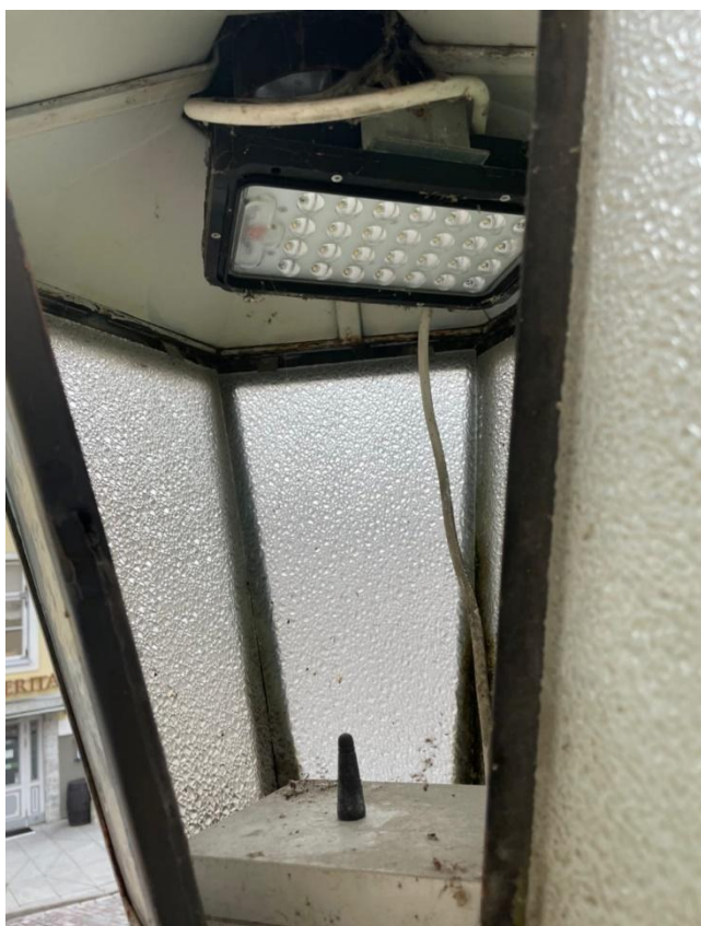
Изображение 8. Светодиодный светильник и маршрутизатор внутри фонаря.
