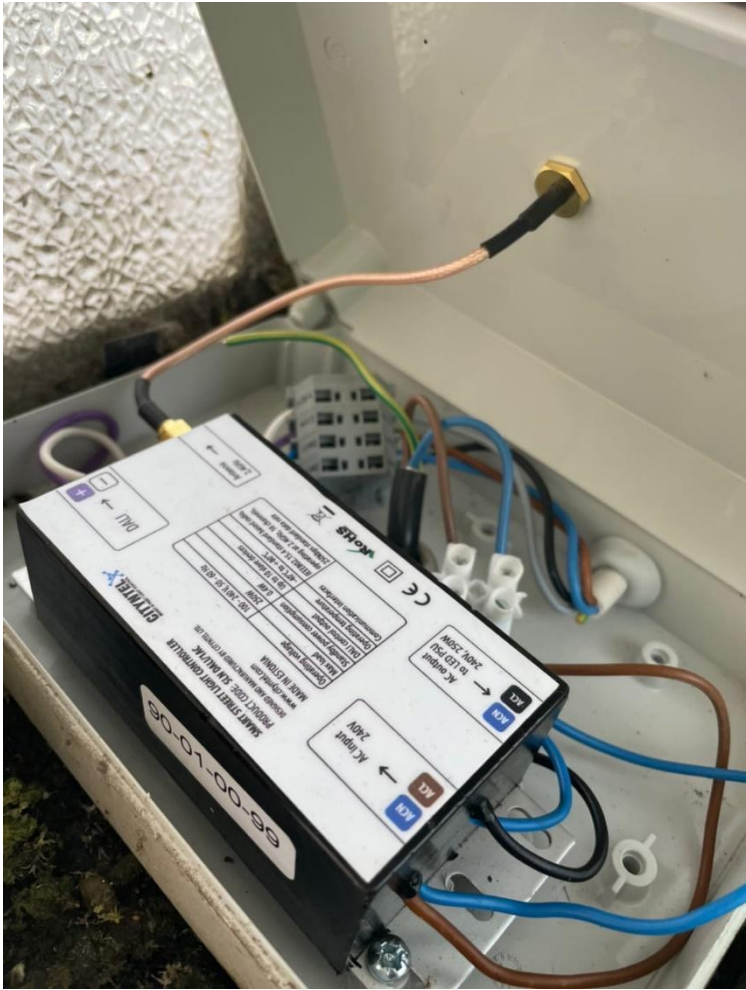
Изображение 9. Блок управления адаптивным освещением в фонаре.
