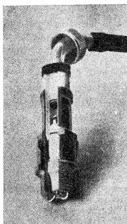
Joon. 6. Veekindlalt ja elektriliselt kapseldatud Bosch'i süüteküünal.
