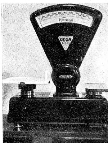
Joon. 5. Kodumaal valmistatav poolautomaatkaal. Kaalumispõirkonna suurendamine toimub väiksemale kaalukaussile asetatavate kilogrammvihtide abil.
