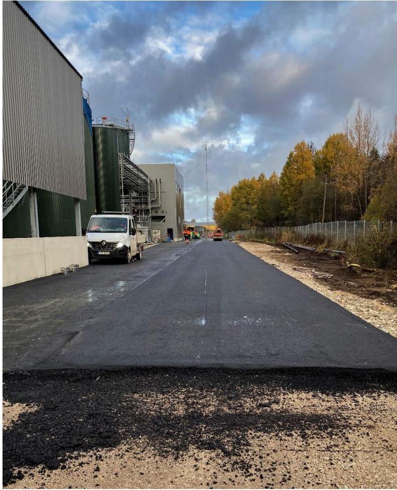
Joonis 3.2 Vaade katselõigule
