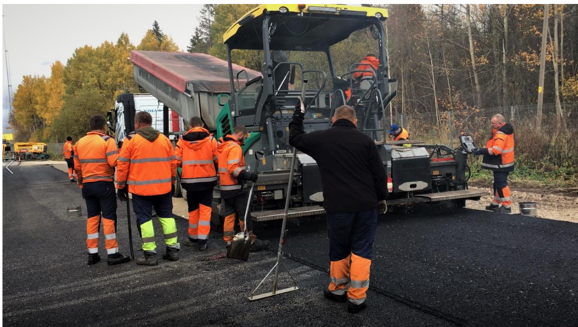
Joonis 3.1 AC 32 base asfaltsegu paigaldamine objektil
