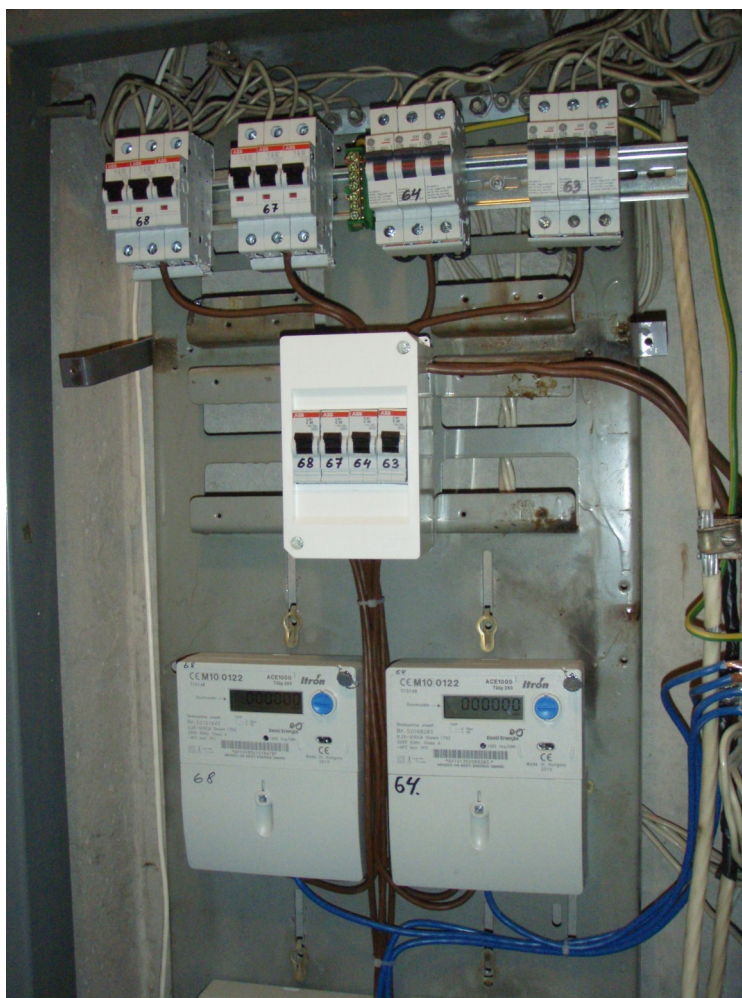
Joonis 5.13: Uuendatud korrusejaotuskeskuse vaade mahavõetud puutekatetega Tallinnas, Lasnamäel asuvas kortermajas[6]
