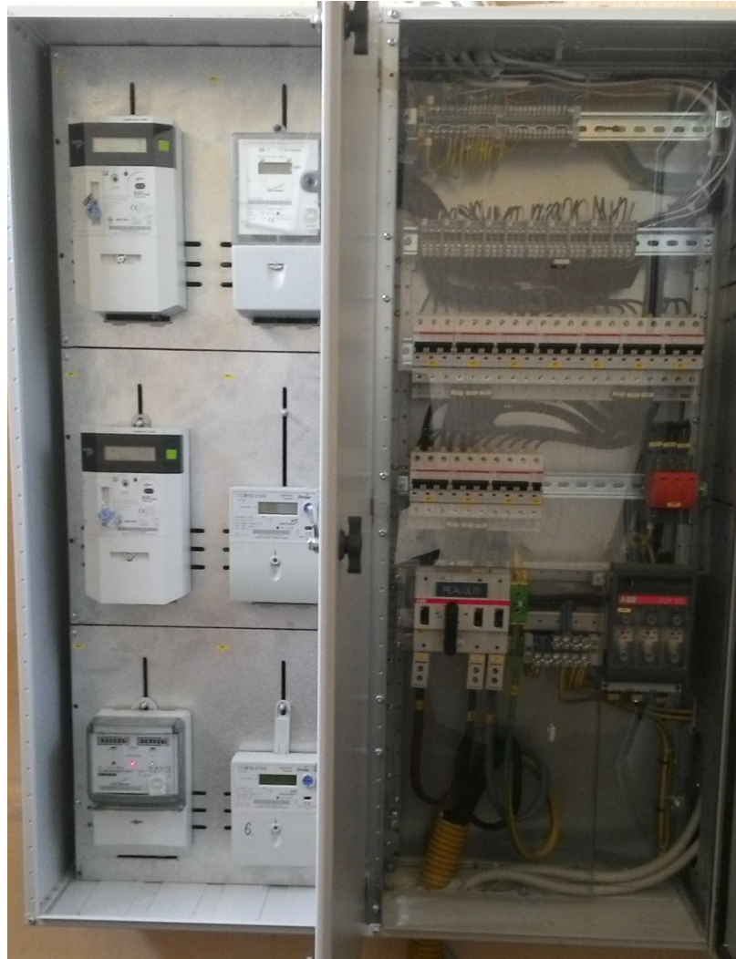
Joonis 5.11: Uuendatud peajaotuskeskuse vaade[6].
