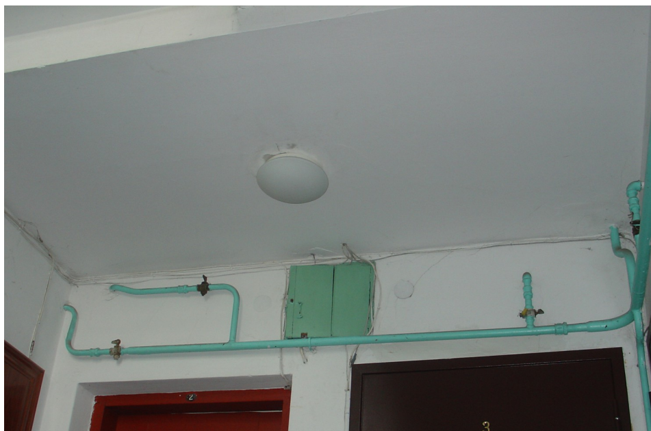
Joonis 5.17: Paigaldatud Steinell RS 16 L valgusti[6]
