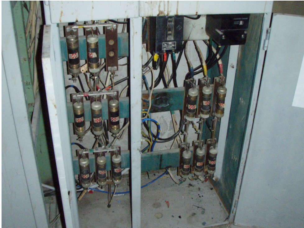
Joonis 4.4 Amortiseerunud peajaotuskeskuse vaade Tallinnas, Mustamäe kortermajas[6]
