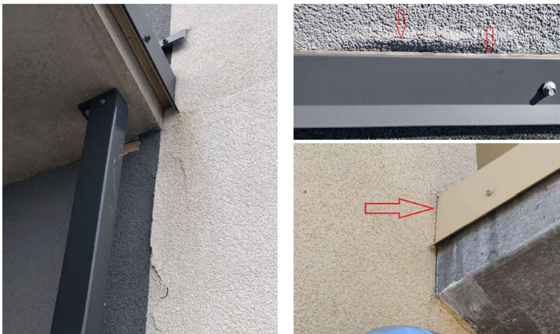
Joonis 3.7: Postidele toestatud rõdult tekkivad niiskuskahjustused. [12]
