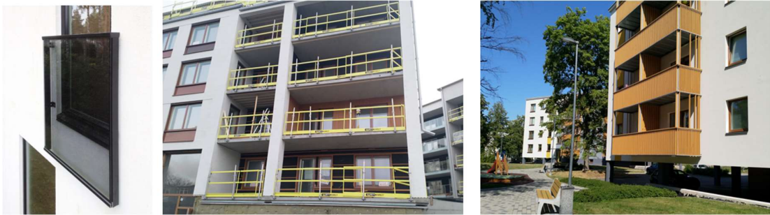
Joonis 3.1: Prantsuse rõdu, lodža ja hoone gabariidist välja ulatuvad rõdud.
