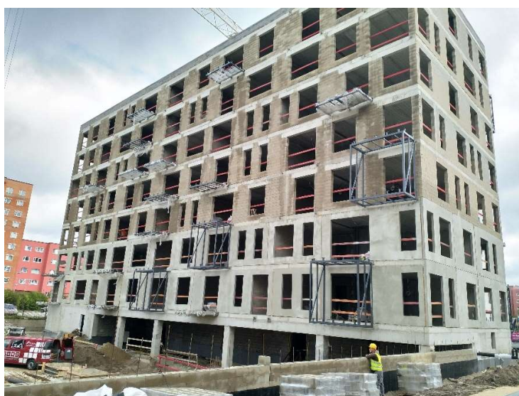
Joonis 3.5: Esiadne konsoolne rõdu terasraami lahendus
