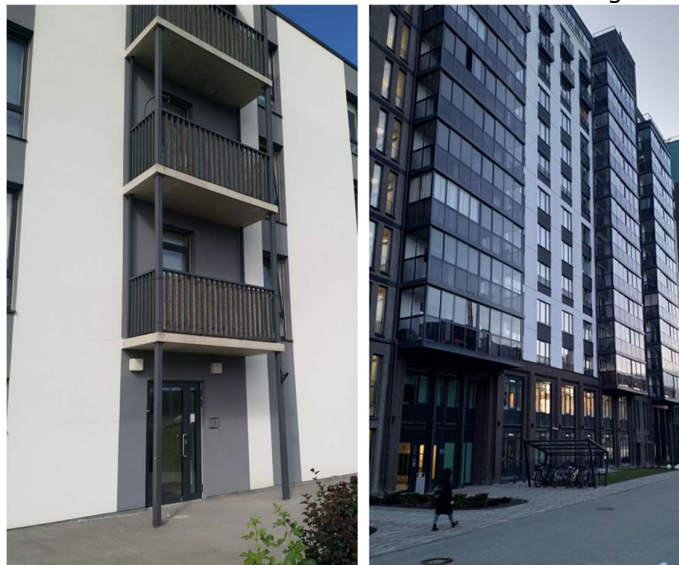
Joonis 3.2: Postidele toetatud ja konsoolsed rõdud
