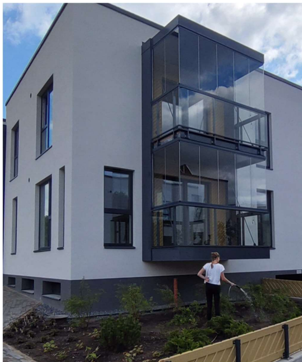
Joonis 5.2: Kinnine rõdu terasraamil tõmbiga
