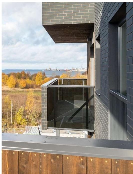
Joonis 4.5: Teraskonstruktsioonil konsoolne rõdu Tallinnas. [12]
