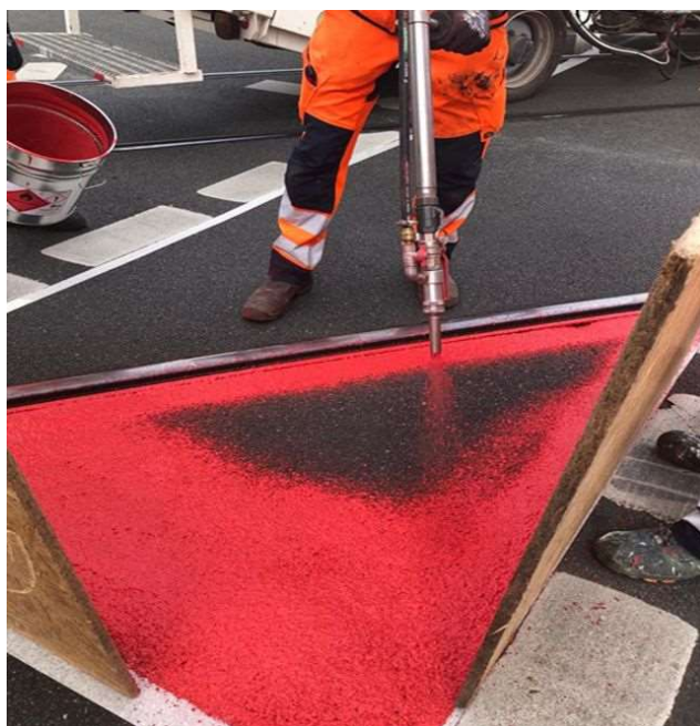
Joonis 1.3. Punase pritsitava külplastiku paigaldamine [20]
