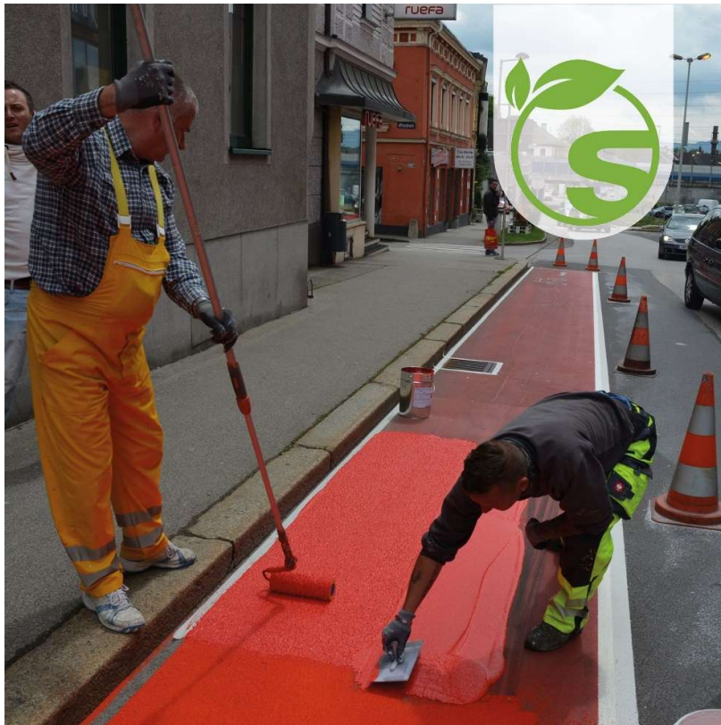
Joonis 1.1. Veebaasil põhineva punase värvi paigaldamine [13]
