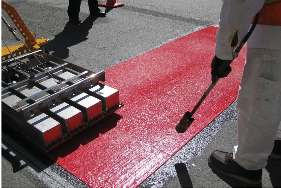
Joonis 1.2. Punase termoplastiku paigaldamine [16]
