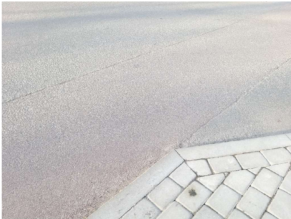
Joonis 3.2. Tartus Viljandi mnt ja Ravila tänava ristmik, punase asfaldi kulumine ristmikul, lähikaader, pilt tehtud 27.03.2024 [Erakogu]
