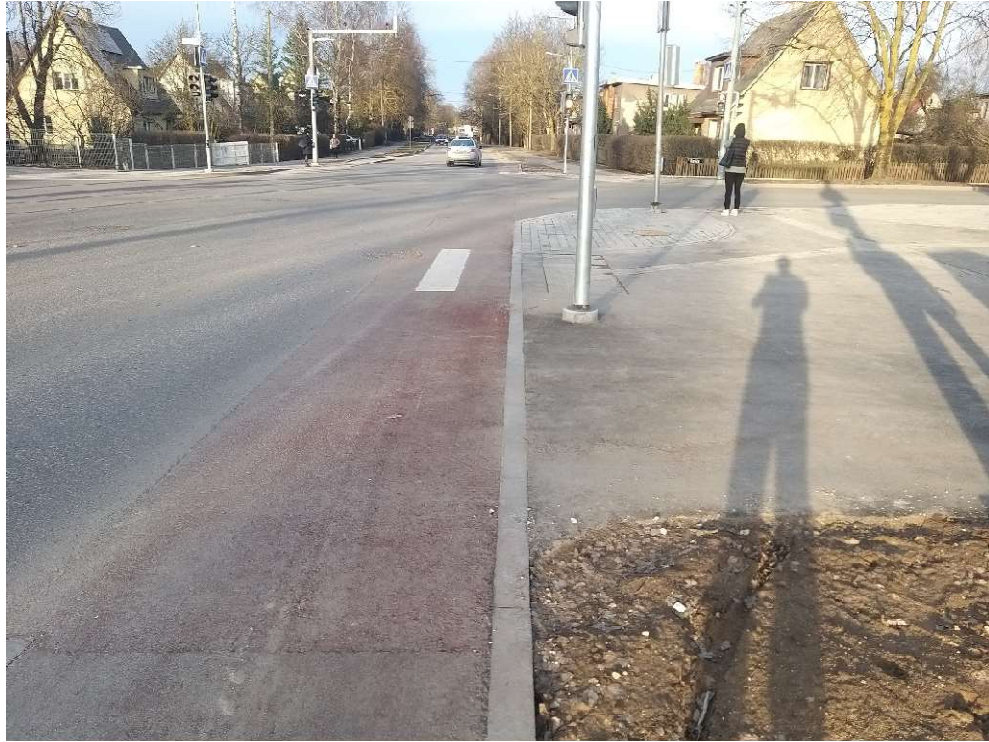
Joonis 3.1. Tartus Viljandi maantee ja Ravila tänava ristmik, punase asfaldi värvi kulumine ristmikul, pilt tehtud 27.03.2024 [Erakogu]
