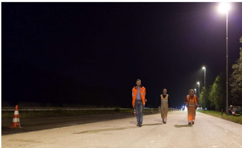
Joonis 2.8. Heleda asfaldi (parem) ja tavapärase musta asfaldi (vasak) nähtavus [45]
