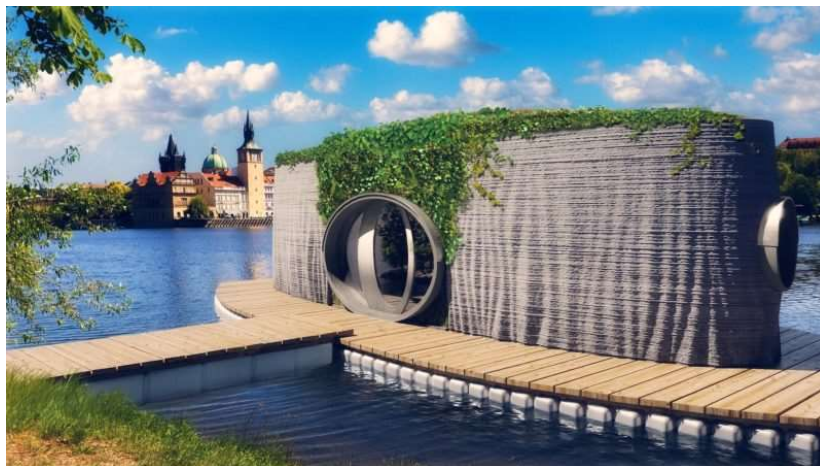
Joonis 3.7. Ujuv 3D prinditud betoonist maja Prahast, Tšehhis. [39]
