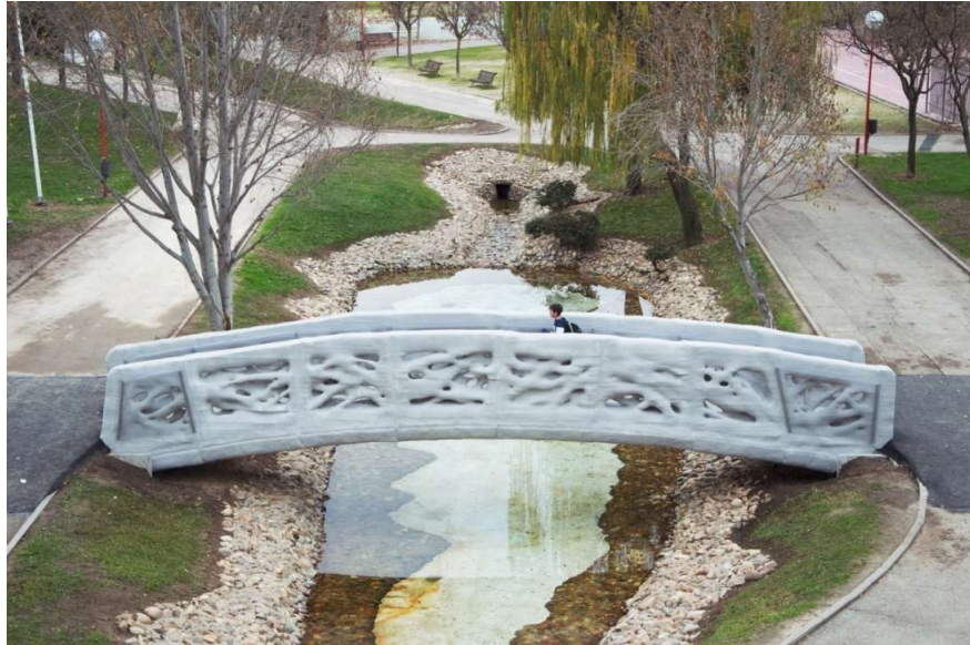
Joonis 3.5. 3D printitud jalakäijate sild Hispaanias Alcobedas. [37]
