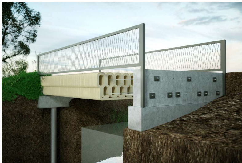
Joonis 3.6. Eelpingestatatud jalakäijate ja jalgratturite sild. [37]
