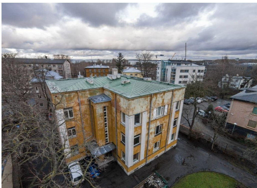
Joonis 3. Objekti renoveerimiseelne välisvaade
