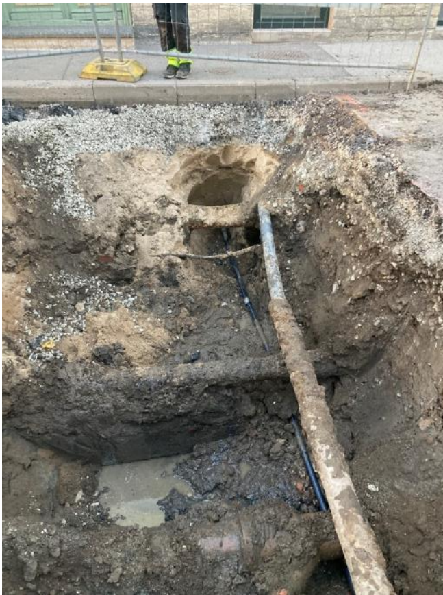
Joonis 37: Järsu üleminekualadega tehtud kaevik katseobjektil Sügise tänav 8.
