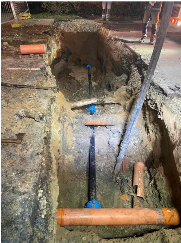
Joonis 40: Järsu üleminekualadega tehtud kaevik katseobjektil Randvere tee 51.
