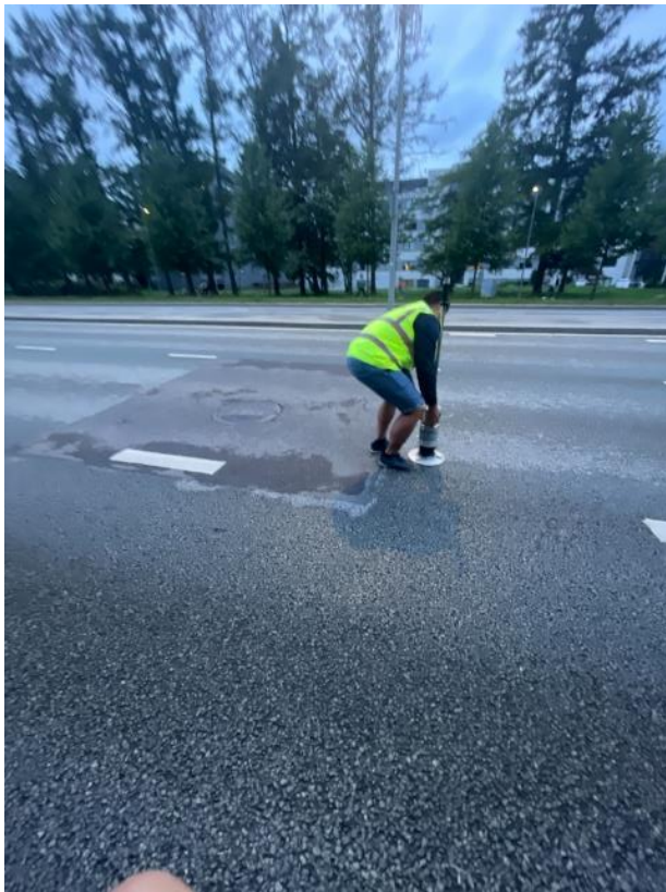
Joonis 21: Asfalteeritud lapi deformeeritavuse mõõtmised Dynatest 3032 LWD deflektomeetriga katseobjektil Ehitajate tee, Õismäe tee 179.
