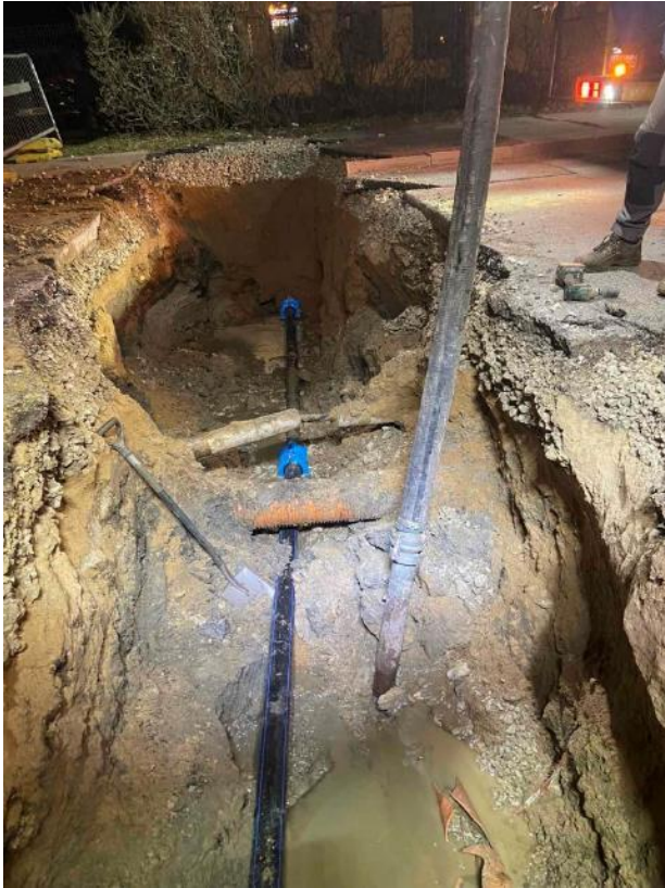
Joonis 39: Järsu üleminekualadega tehtud kaevik katseobjektil Randvere tee 51.
