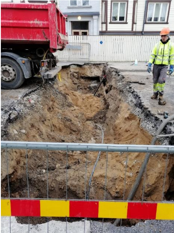
Joonis 25: Kaldega üleminekualadega tehtud kaevik katseobjektil Härjapea tänav 23.
