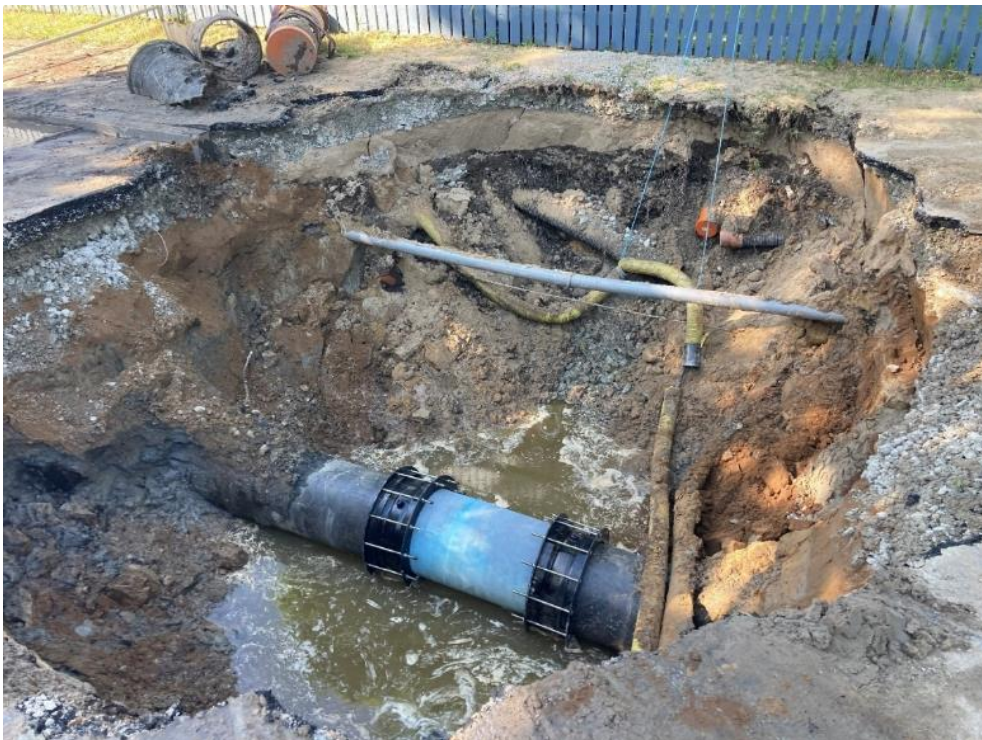
Joonis 10: Kaldega üleminekualadega tehtud kaevik katseobjektil Räägu tänav 13.
