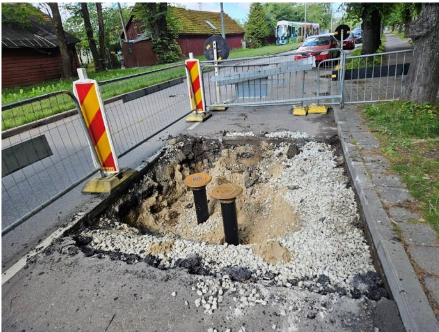
Joonis 2: Kaldega üleminekualadega tehtud kaevik katseobjektil Kopli tänav 48.
