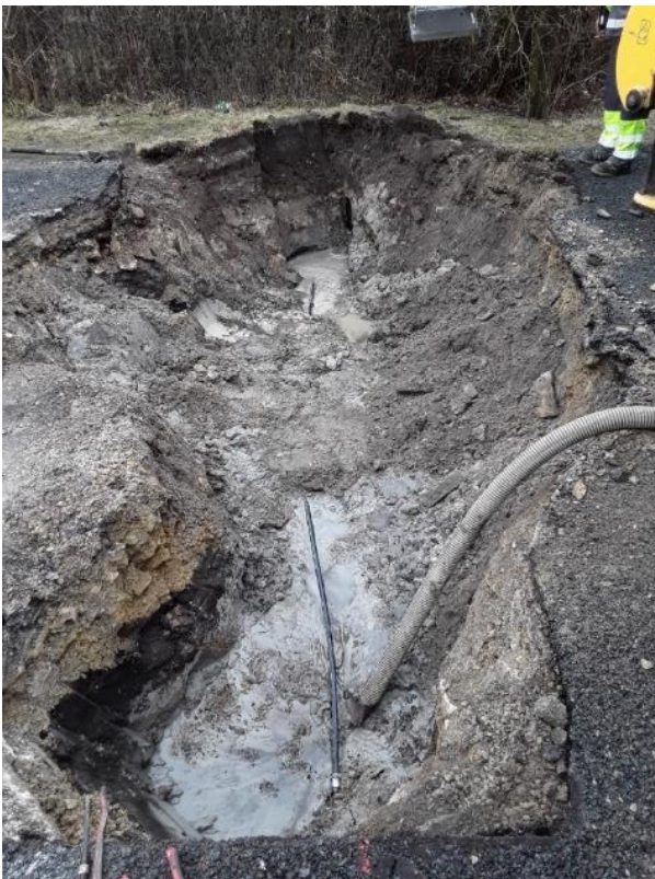
Joonis 22: Kaldega üleminekualadega tehtud kaevik katseobjektil Looga tänav 15.
