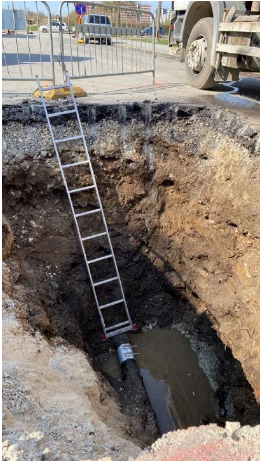
Joonis 31: Järsu üleminekualadega tehtud kaevik katseobjektil Paasiku tänav 6.
