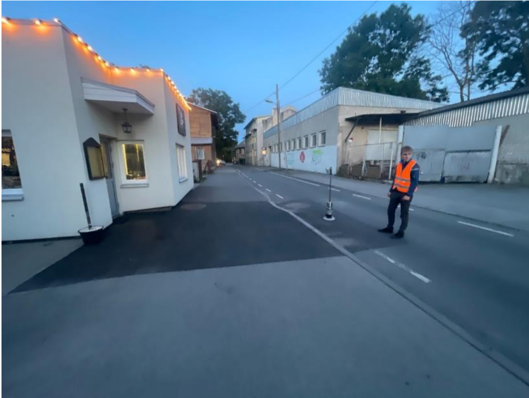
Joonis 45: Asfalteeritud lapi deformeeritavuse mõõtmised Dynatest 3032 LWD deflektomeetriga katseobjektil Vabriku tänav 6.
