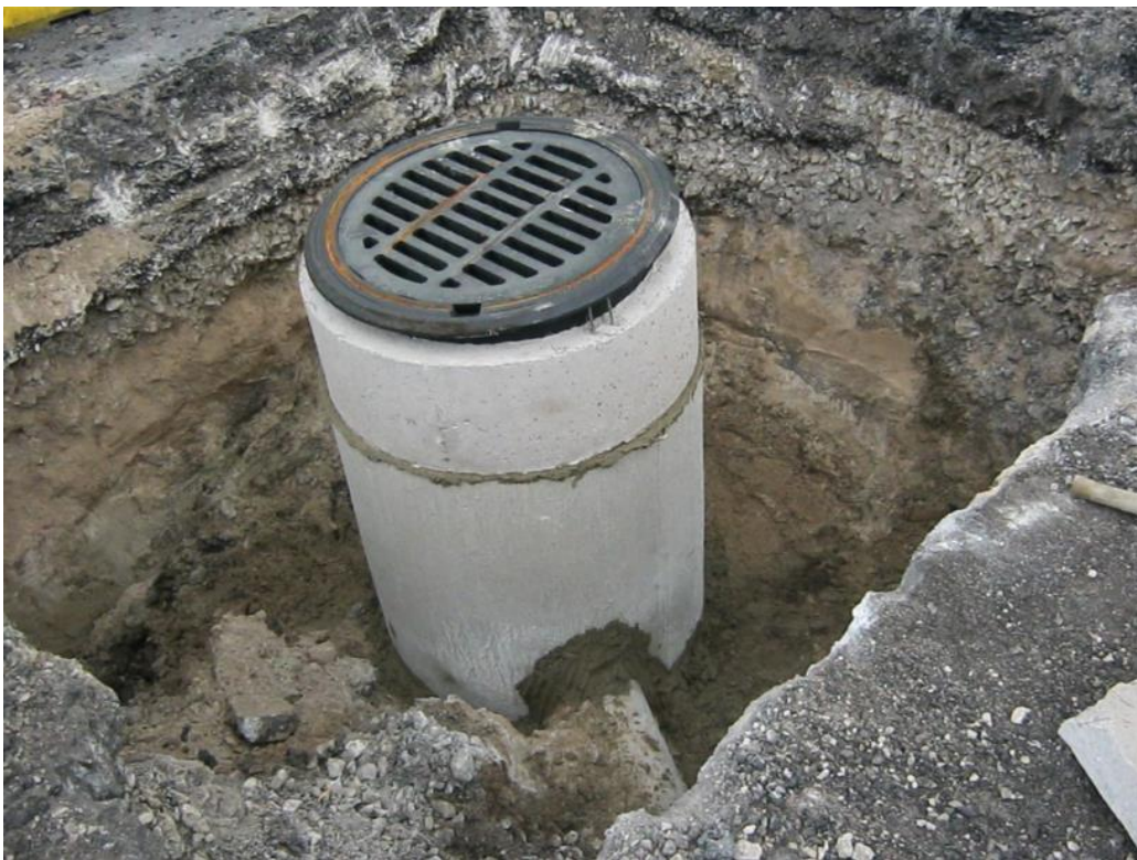
Joonis 48: Järsu üleminekualadega tehtud kaevik katseobjektil Õismäe tee 8.
