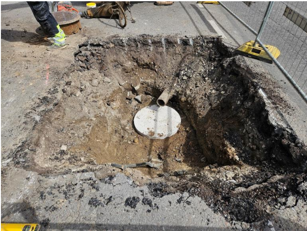
Joonis 4: Kaldega üleminekualadega tehtud kaevik katseobjektil Mulla tänav 2.
