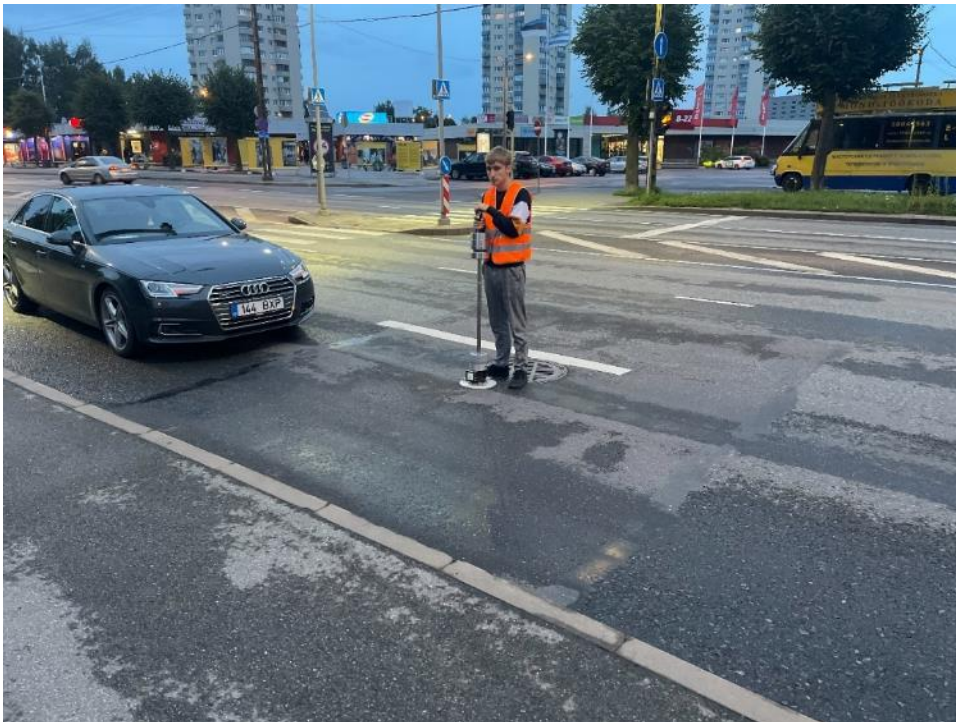
Joonis 49: Asfalteeritud lapi deformeeritavuse mõõtmised Dynatest 3032 LWD deflektomeetriga katseobjektil Õismäe tee 8.
