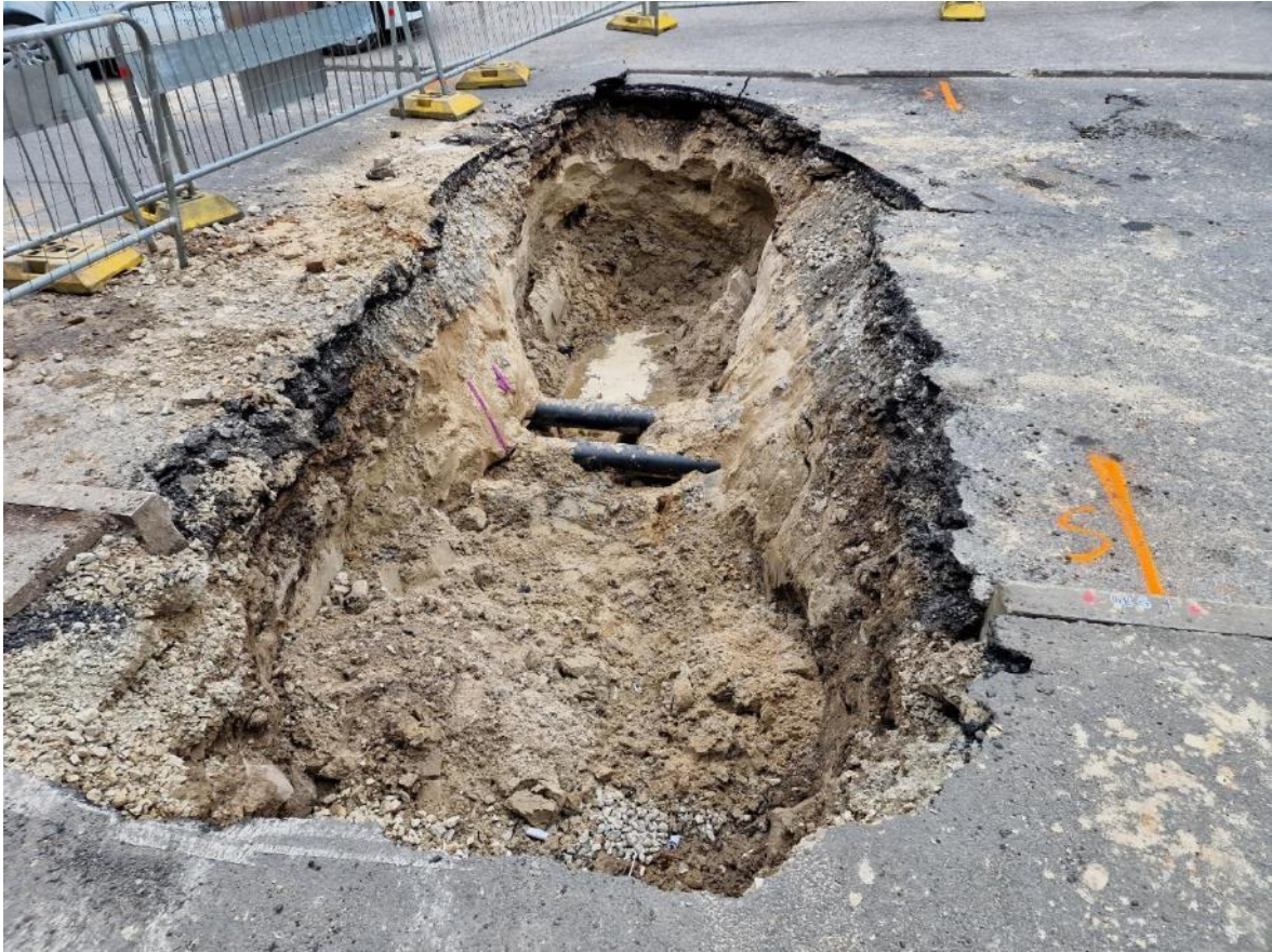
Joonis 7: Kaldega üleminekualadega tehtud kaevik katseobjektil Keemia tänav 16.
