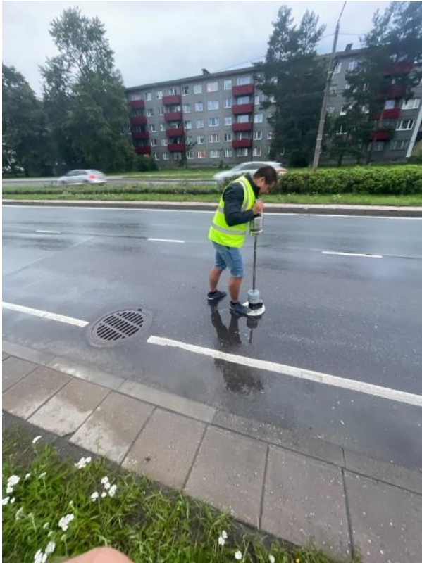
Joonis 51: Asfalteeritud lapi deformeeritavuse mõõtmised Dynatest 3032 LWD deflektomeetriga katseobjektil Sõpruse puiestee 219.
