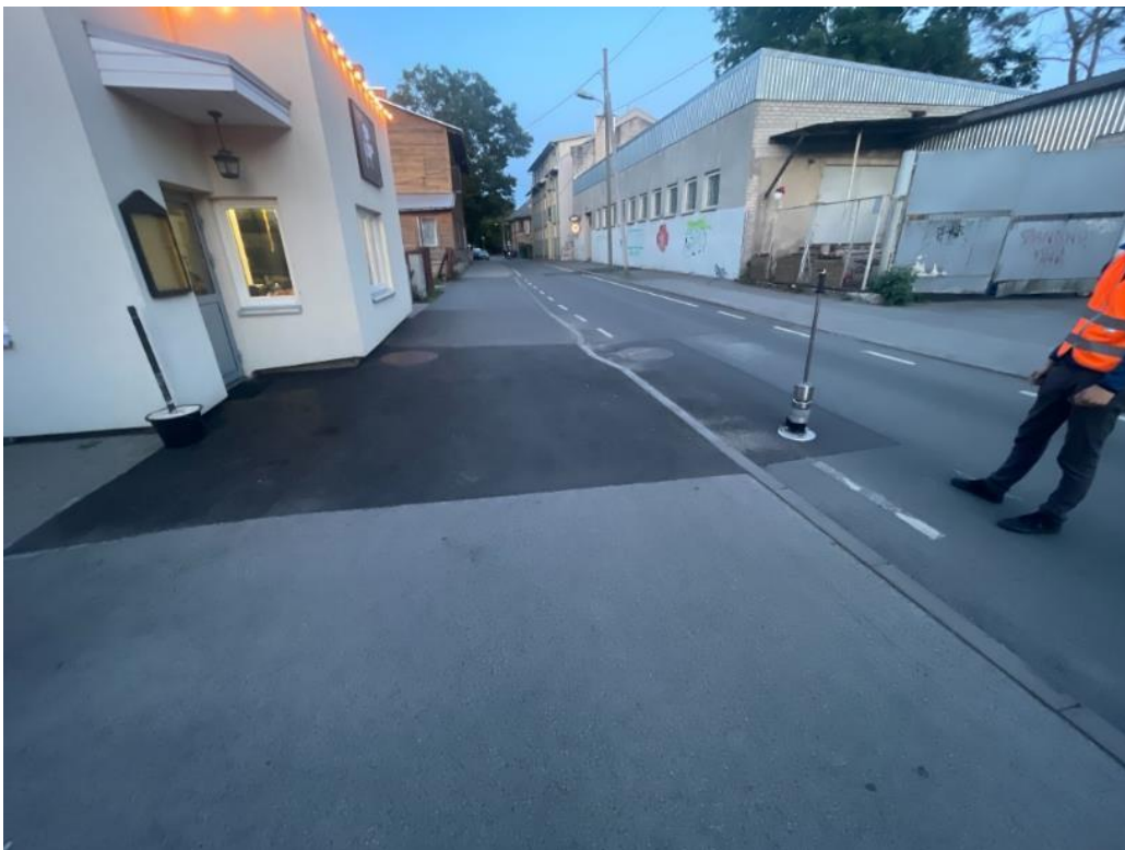
Joonis 46: Asfalteeritud lapi deformeeritavuse mõõtmised Dynatest 3032 LWD deflektomeetriga katseobjektil Vabriku tänav 6.
