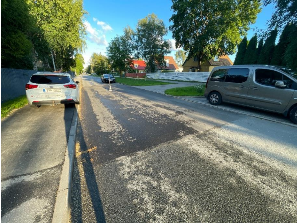
Joonis 11: Asfalteeritud lapi deformeeritavuse mõõtmised Dynatest 3032 LWD deflektomeetriga katseobjektil Räägu tänav 13.
