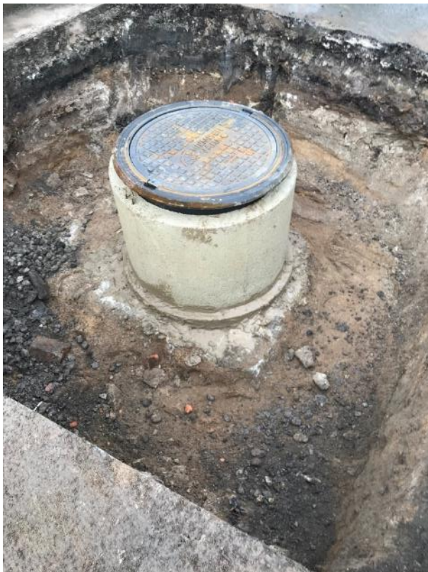
Joonis 52: Järsu üleminekualadega tehtud kaevik katseobjektil Rästa tänav 2a.
