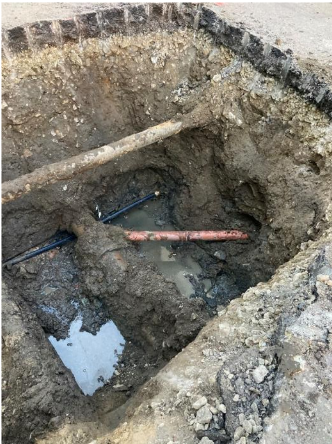
Joonis 36: Järsu üleminekualadega tehtud kaevik katseobjektil Sügise tänav 8.
