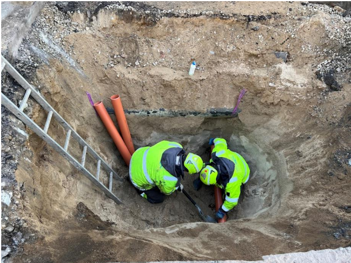
Joonis 15: Kaldega üleminekualadega tehtud kaevik katseobjektil Tondi tänav 3.
