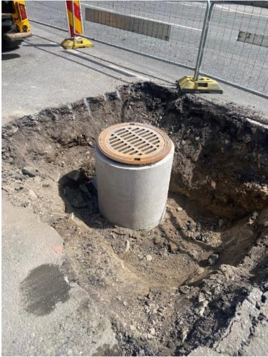
Joonis 5: Kaldega üleminekualadega tehtud kaevik katseobjektil Mulla tänav 2.
