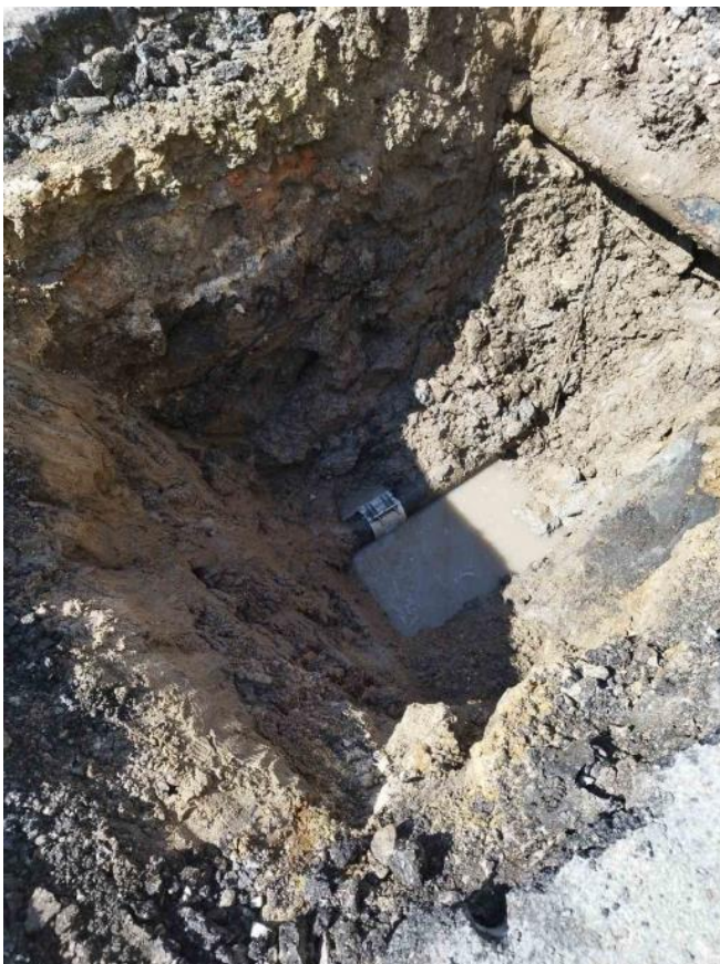
Joonis 28: Järsu üleminekualadega tehtud kaevik katseobjektil Komeedi tänav 4.
