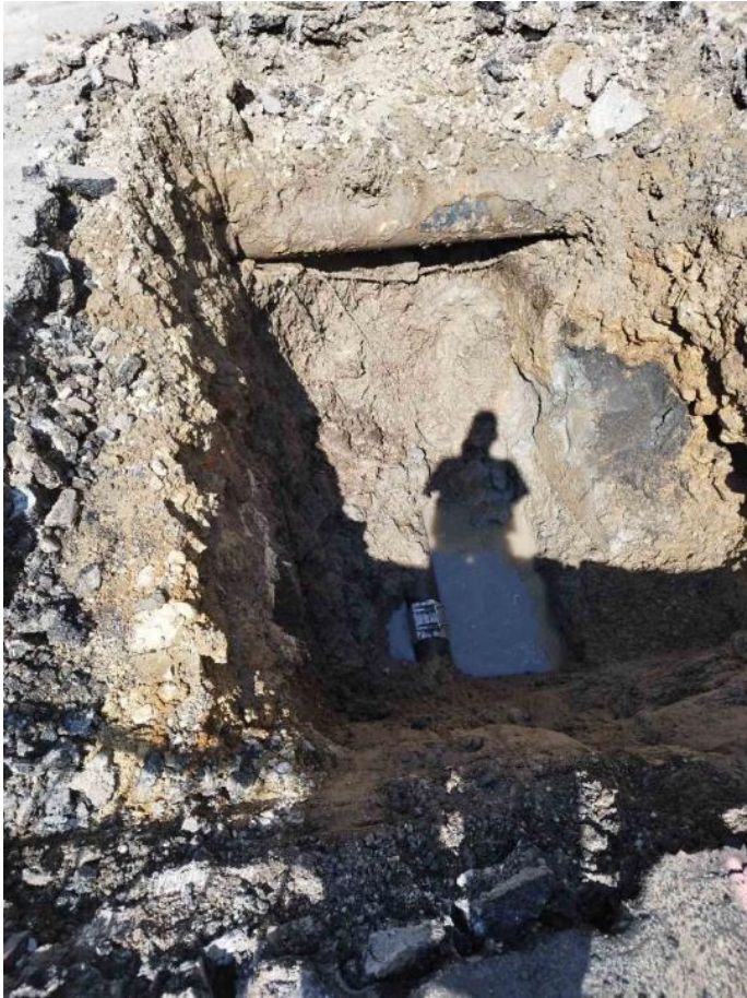
Joonis 29: Järsu üleminekualadega tehtud kaevik katseobjektil Komeedi tänav 4.
