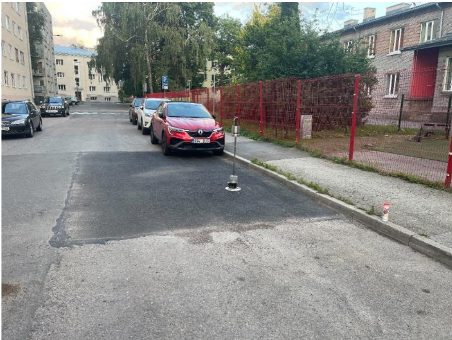
Joonis 30: Asfalteeritud lapi deformeeritavuse mõõtmised Dynatest 3032 LWD deflektomeetriga katseobjektil Komeedi tänav 4.
