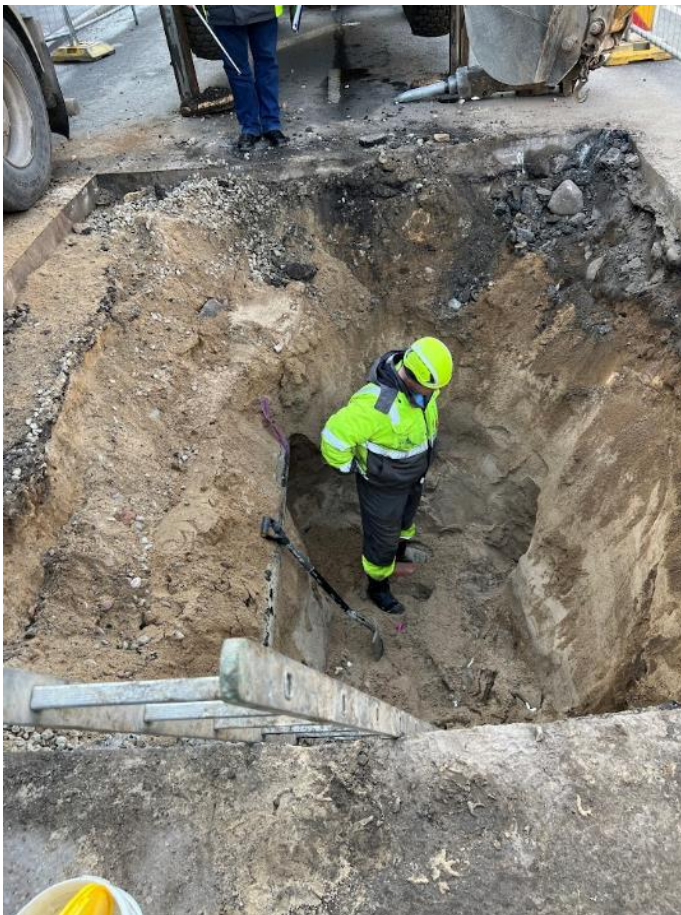
Joonis 14: Kaldega üleminekualadega tehtud kaevik katseobjektil Tondi tänav 3.
