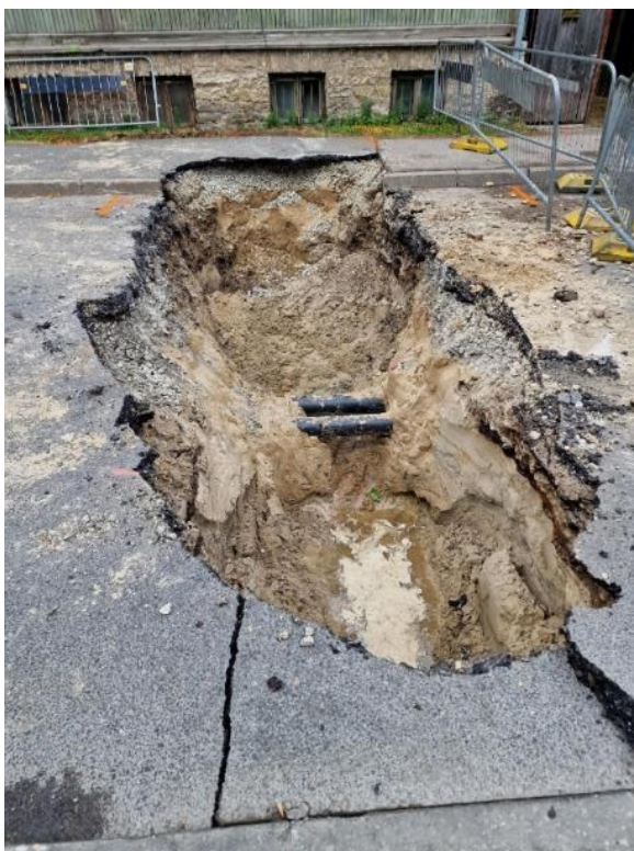
Joonis 8: Kaldega üleminekualadega tehtud kaevik katseobjektil Keemia tänav 16.
