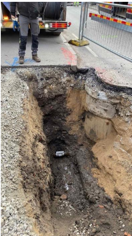
Joonis 44: Järsu üleminekualadega tehtud kaevik katseobjektil Vabriku tänav 6.
