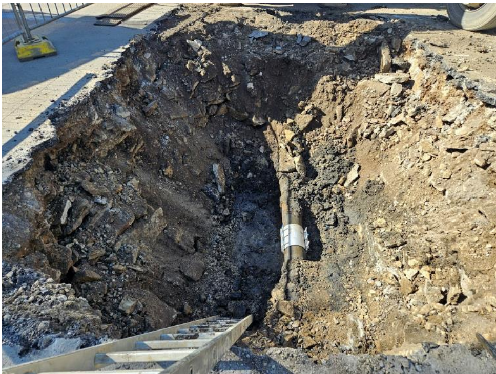
Joonis 12: Kaldega üleminekualadega tehtud kaevik katseobjektil Lasnamäe tänav 32.
