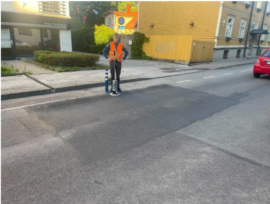
Joonis 35: Asfalteeritud lapi deformeeritavuse mõõtmised Dynatest 3032 LWD deflektomeetriga katseobjektil J. Vilmsi tänav 32.
