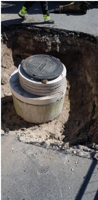
Joonis 55: Järsu üleminekualadega tehtud kaevik katseobjektil Puuvilla tänav 32.
