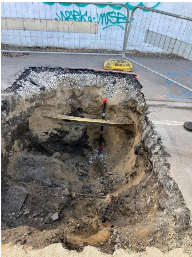
Joonis 42: Järsu üleminekualadega tehtud kaevik katseobjektil Vabriku tänav 4.
