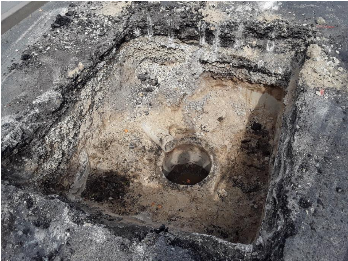
Joonis 47: Järsu üleminekualadega tehtud kaevik katseobjektil Õismäe tee 8.
