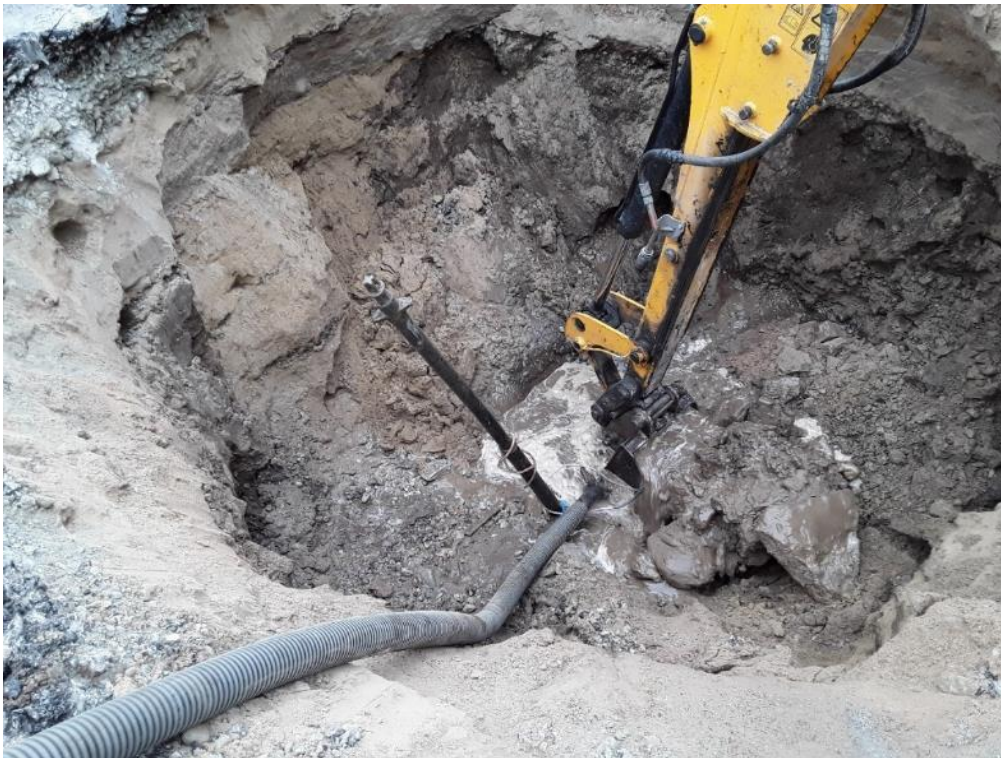
Joonis 17: Kaldega üleminekualadega tehtud kaevik katseobjektil Suur-Sõjamäe tänav 6.
