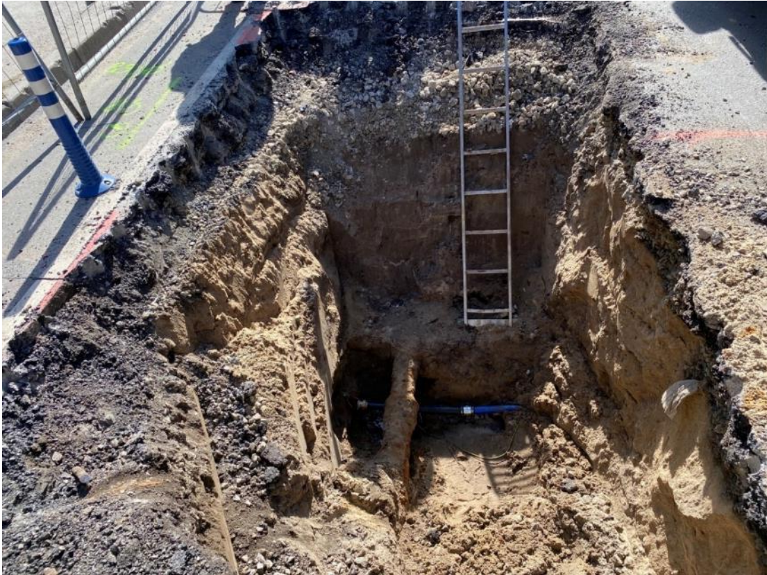
Joonis 33: Järsu üleminekualadega tehtud kaevik katseobjektil J. Vilmsi tänav 32.
