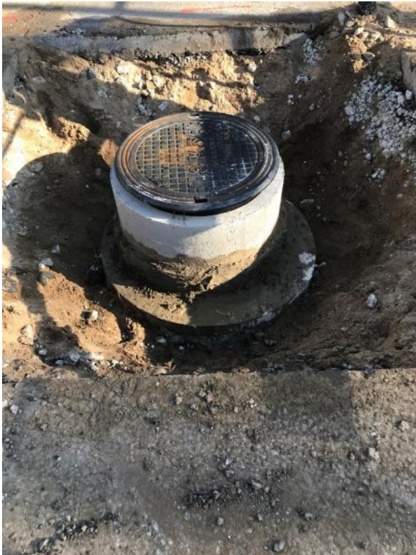
Joonis 19: Kaldega üleminekualadega tehtud kaevik katseobjektil Ehitajate tee, Õismäe tee 179.
