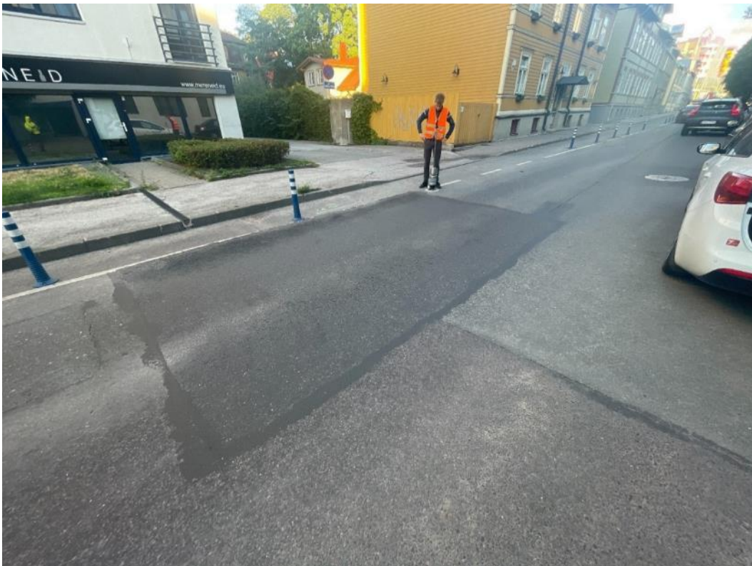
Joonis 34: Asfalteeritud lapi deformeeritavuse mõõtmised Dynatest 3032 LWD deflektomeetriga katseobjektil J. Vilmsi tänav 32.
