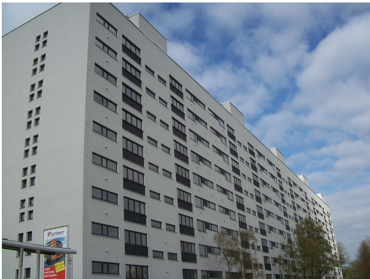
Foto 2. Renoveeritud Sõpruse pst 202 korterelamu
