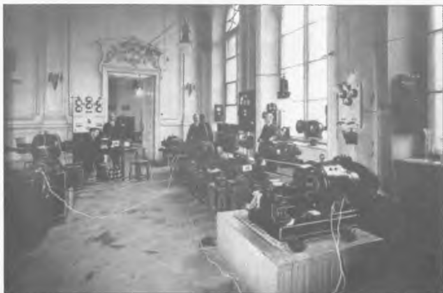
Elektrotehnika tugevvoolu laboratoorium. Masinaruum
