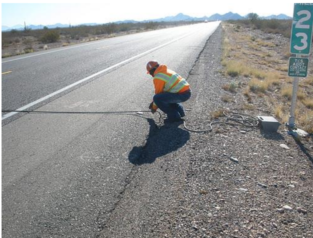
Joonis 6. Õhuvooliku paigaldamine [17]
