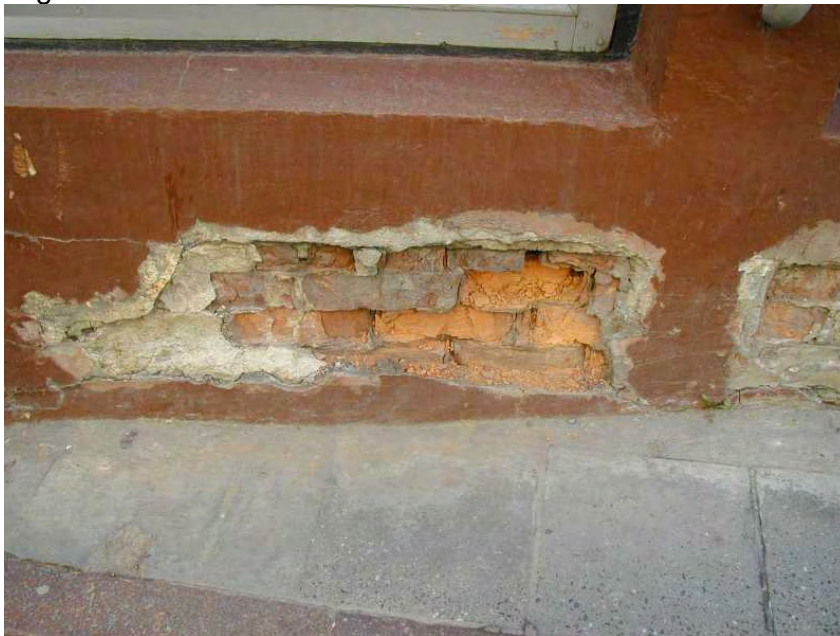
Niiskuse kondenseerumine seinas, vesi jääb ja purendab müüritist
