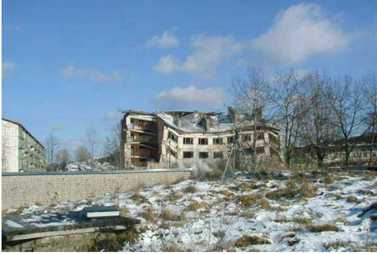
Plokkelamu Paldiskis (laengute järjestikuline lõhkamine)
