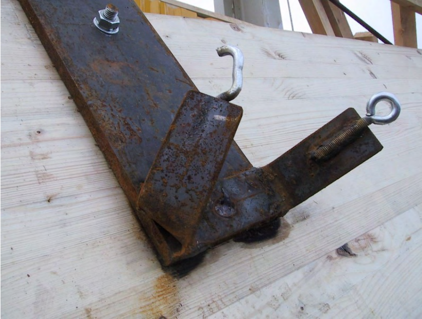
Sidemete nõrgad kinnituselemendid sõlmedes
