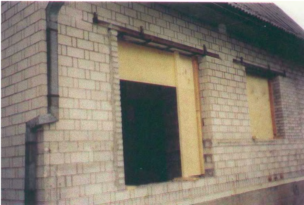
Olemasoleva ava suurendamine terasprofiilidega
