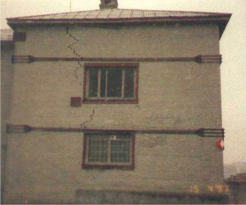
Tellisseina tugevdamine terastõmbidega (hoone ebaühtlane vajumine)
