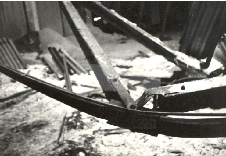
Puit-metallsõrestike varing ülisaledate sõlmlappide stabiilsuse kao tõttu
