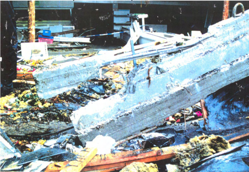
R/b tala purunemine toel rangide ja ülespöörete puudumise tõttu
