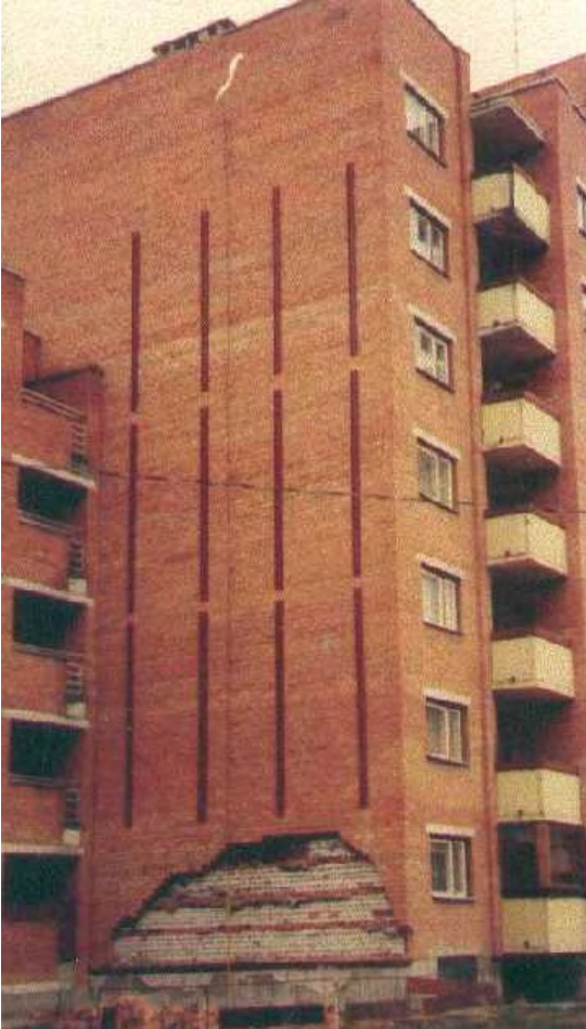
Tellisseina välisvoodri kinnitamine terasprofiilide paigaldamisega
