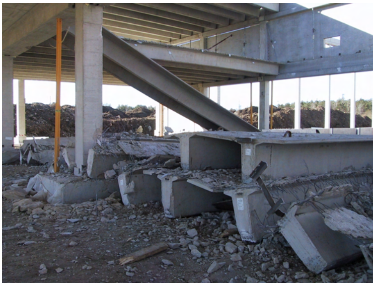
Ehituse ajal TT paneelidest lae varing nende paneelide lõugtaladele vigase toetuse tõttu
