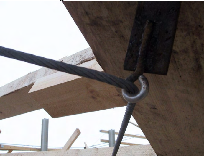
Sidemete nõrgad kinnituselemendid sõlmedes
