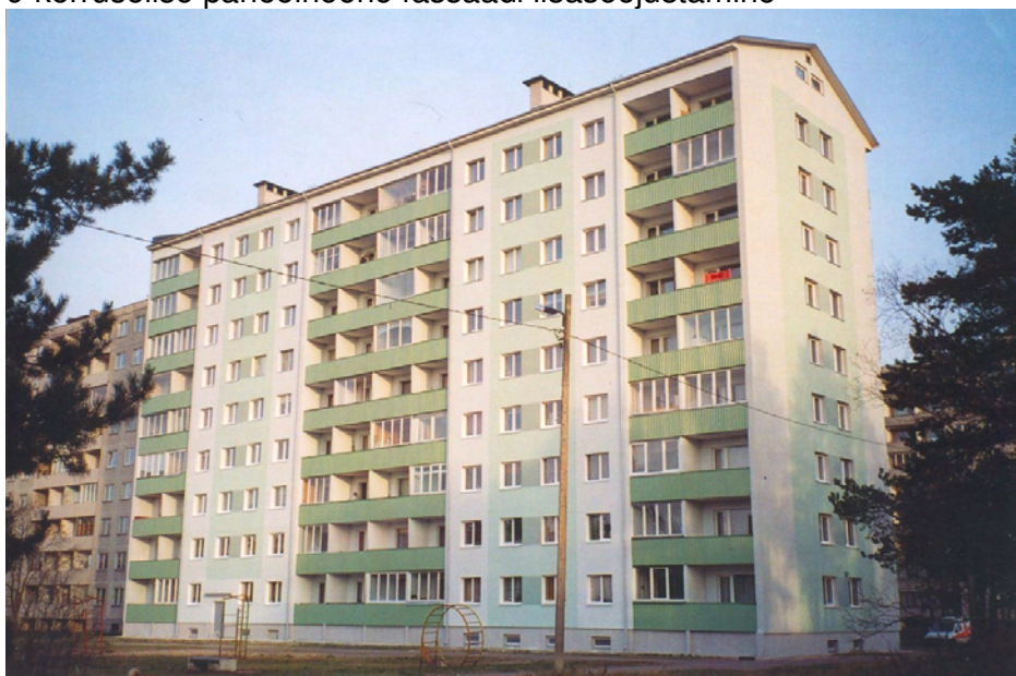
Renoveeritud 9-korruselise paneelhoone fassaad
