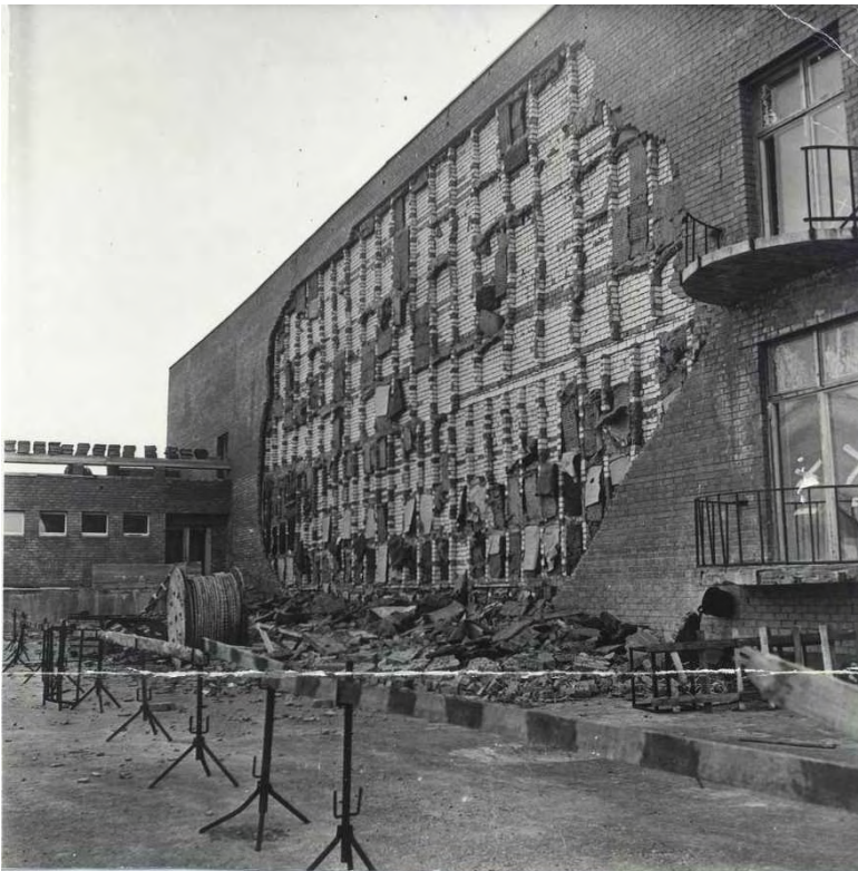
Kivivoodri varing müüritise kandva osaga vigase sideme tõttu
