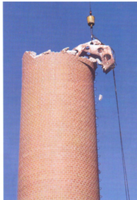
Abb. 4.10: Schornsteinabbruch mit einem am Kran hängenden Pulverisierer
