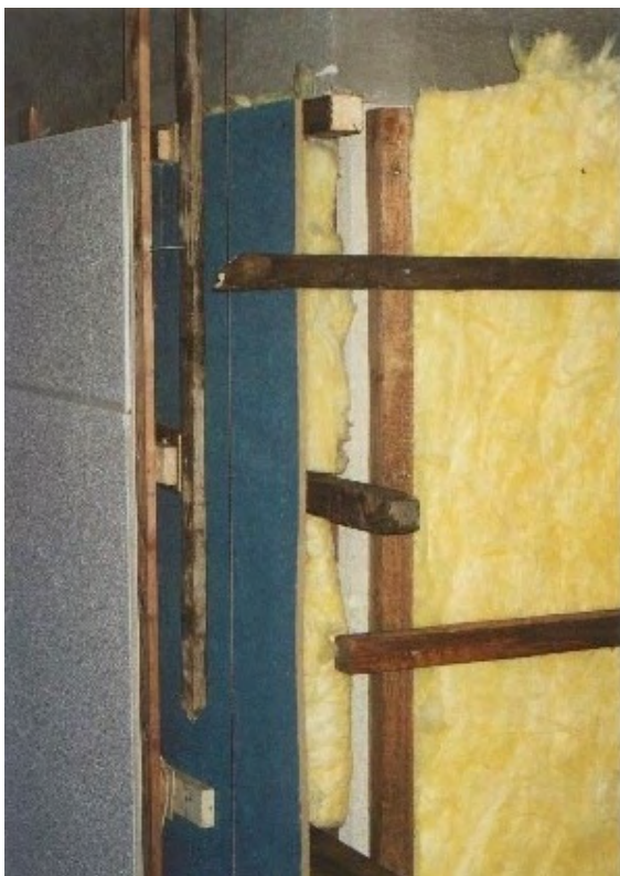
9-korruselise paneelhoone fassaadi lisasoojustamine
