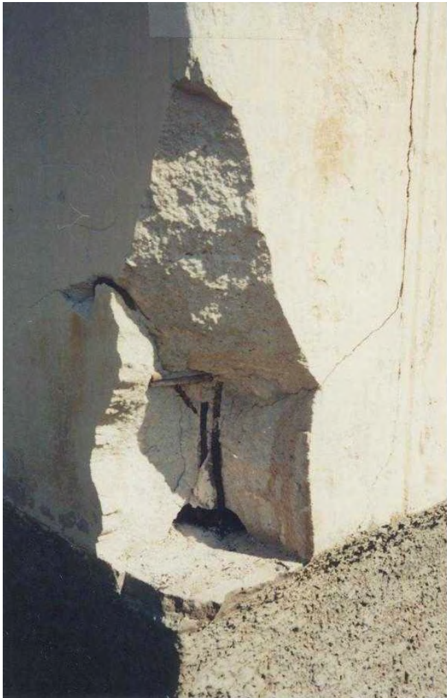
Gaassilikaltsiidi sarrusterase (tarilapi) korrosioonikahjustused
