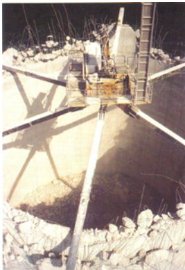
Abb. 4.9: Ferngesteuerter Abbruchroboter auf einem 6-armigen Auslegersystem
