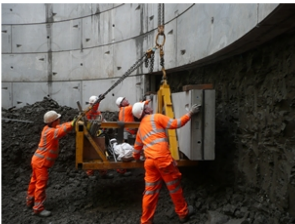
Joonis 11 Toestiku paigaldamine [24]
