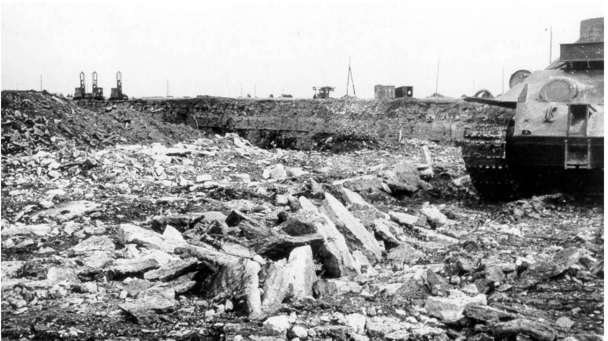
Pilt 3.9 Paekihtide kobestamine Pildile on jäänud osa tankist, mis terasvannasega paasi kündis.
