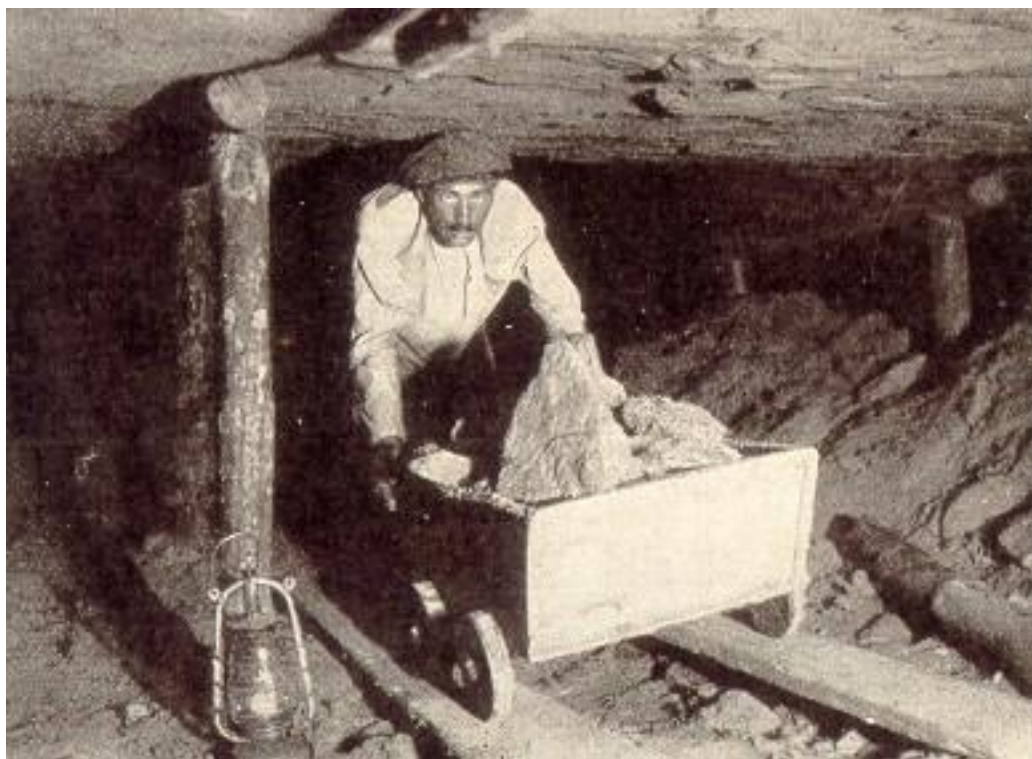
Pilt 1.16 Kaevisel tarimine Ülgase allmaakaevanduses enne 1939. ja Estonia põlevkivikaevanduses kaasajal.
