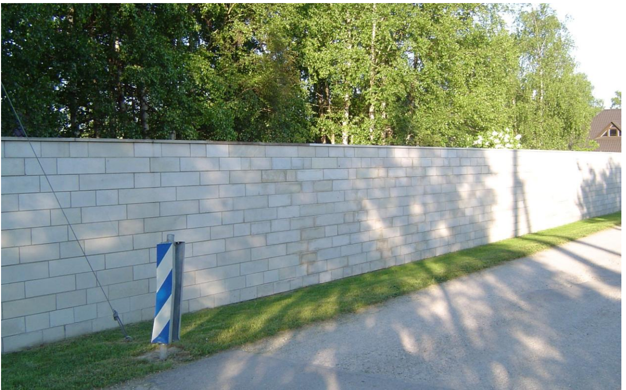
Pilt 3.30 Lõigatud tükkidest laotud ilmetu müür eramu varjamiseks N 59°28'31,5"; E 24°57'48,3"
