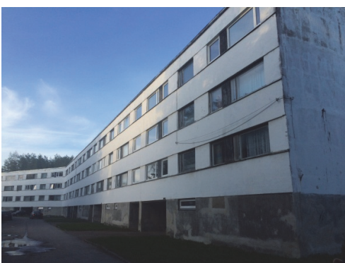
LISA 2, Foto 8. Lintaknad hoovipoolsel fassaadil.
