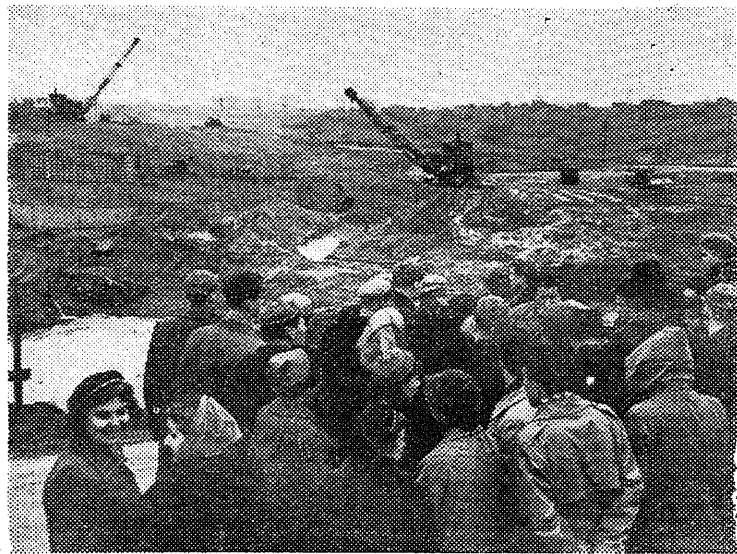
Balti liiduvabariikide ja Valgevene NSV üliõpilaste V teaduslik konverentsist osavõtjad käisid ekskursioonil ka Kaunase elektrijaama ehitusel. H. Arraku foto
