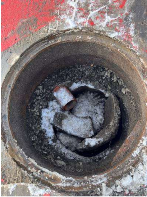
Joonis 1.4 Tamponeeritud kaev [Erakogu]
