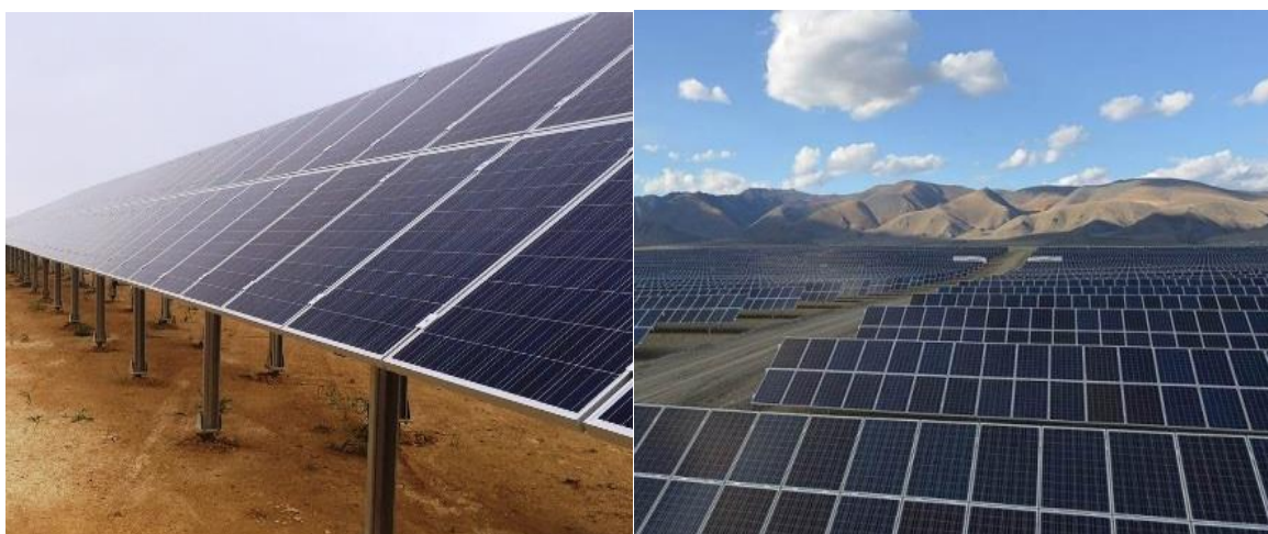
Joonis 1.6.3. Fotoelektriline päikeseelektrijaam [50]
