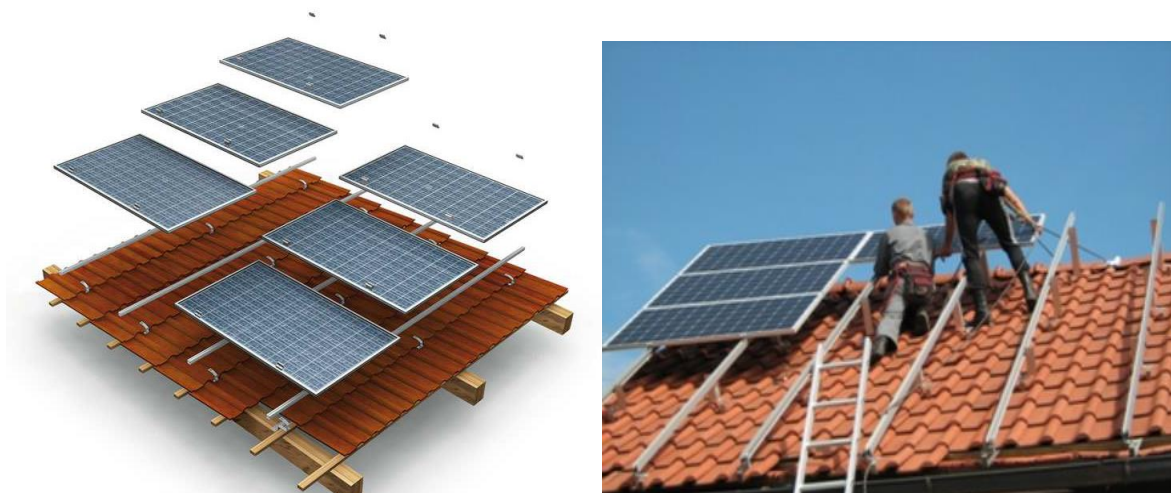
Joonis 2.3.2. Päikesepaneelide paigutamine kivi katuse peale [63]
