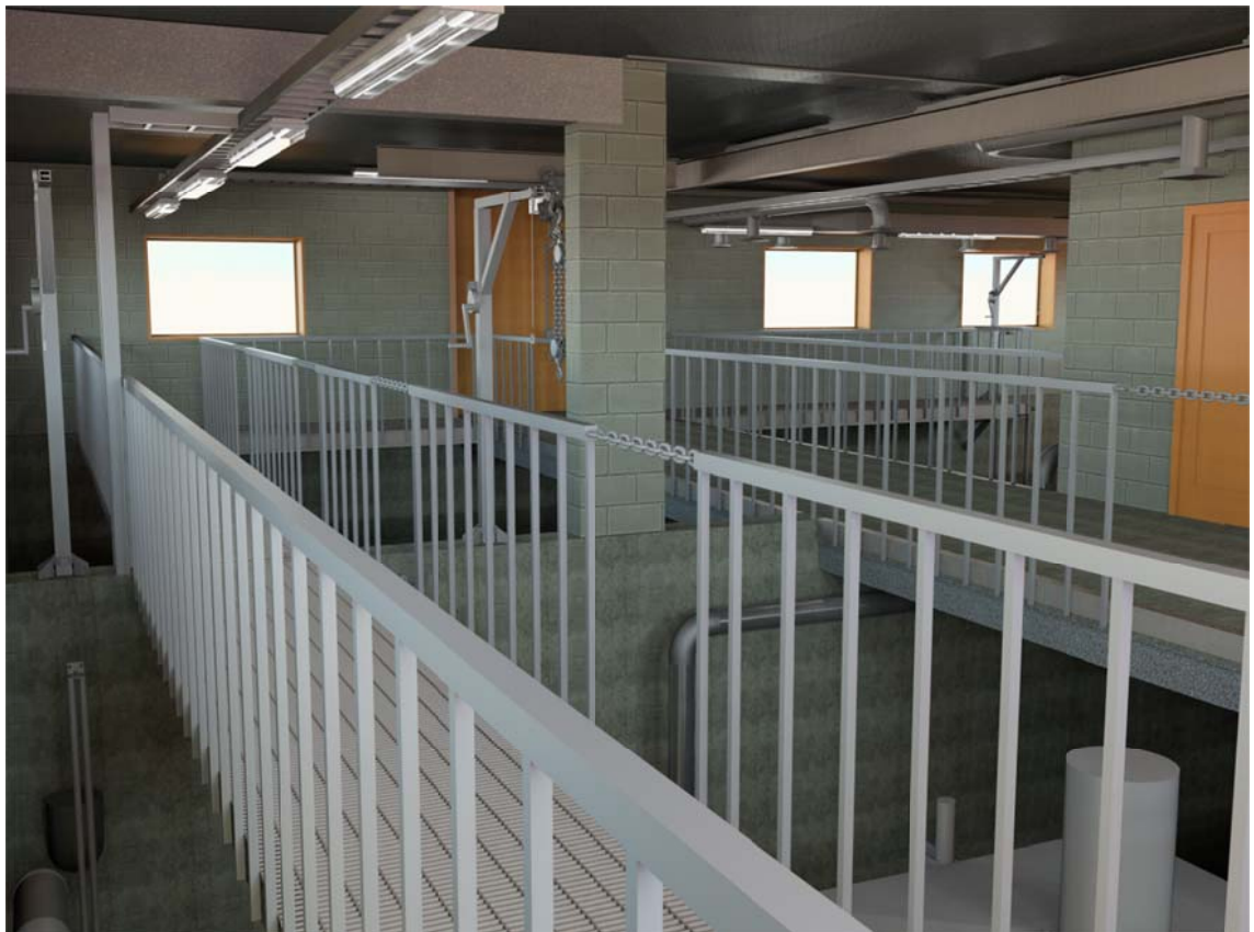
Joonis 19. SBR mahutite pealne ruum koos käiguteedega.
