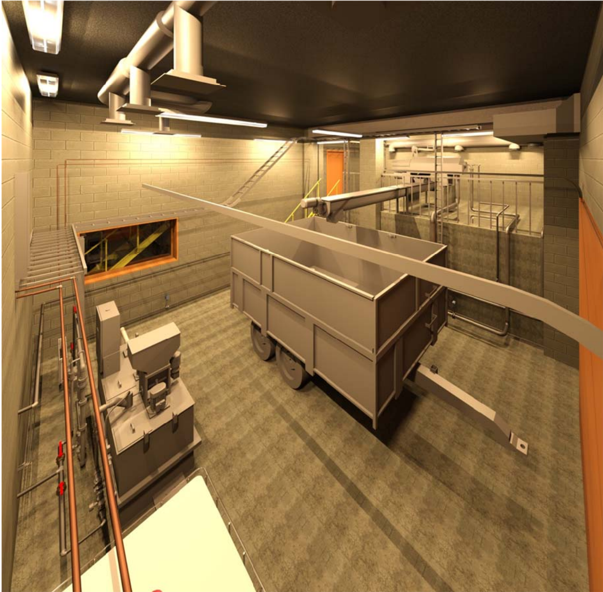
Joonis 20. Reoveesette tahendamise ruum.
