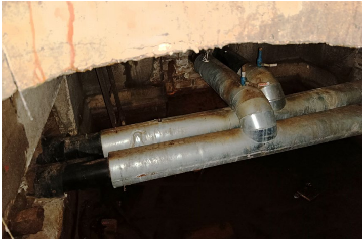
Joonis 5.16. Nõukogudeaegse kaugküttetorustiku kambri sisu. Kambri põhjas on vesi. Allikas: Inseneribüroo REIB OÜ fotokogu.
