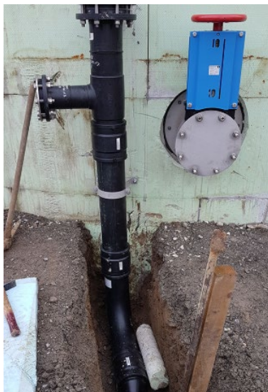
Joonis 5.20. Gaasitorustiku ühenduskoht. 24
