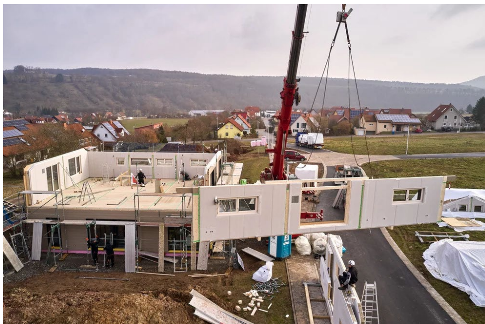
Joonis 13.1. Suurpaneelhoone montaaž 49 .
