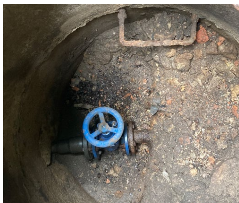
Joonis 5.4. Veetorustiku sulgeseade kaevus (peatorustik mattunud) ja maapealne hüdrant. Allikas: Inseneribüroo REIB OÜ fotokogu.
