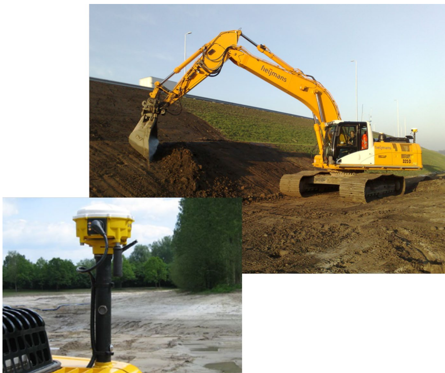
Joonis 5.28. Ekskavaatori töö juhtimine RTK-GNSS abil 27 .
