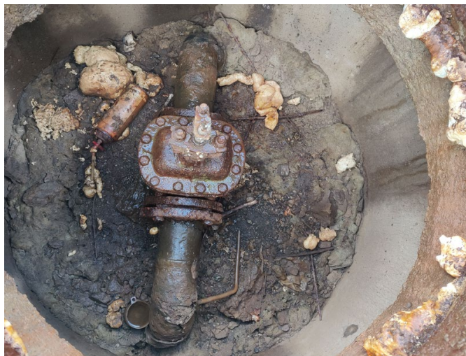
Joonis 5.19. Nõukogude ajast pärit gaasitorustiku kaev sulgeseadmega (siibriga). Allikas: Inseneribüroo REIB OÜ fotokogu.
