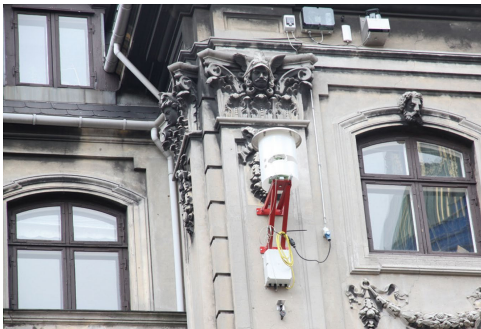
Joonis 19.23. Kopenhaageni metroo rajamise ajaks hoone fassaadile monteeritud automatiseeritud robottahhümeeter deformatsioonide vaatluseks (Chmelina jt, 2016).
