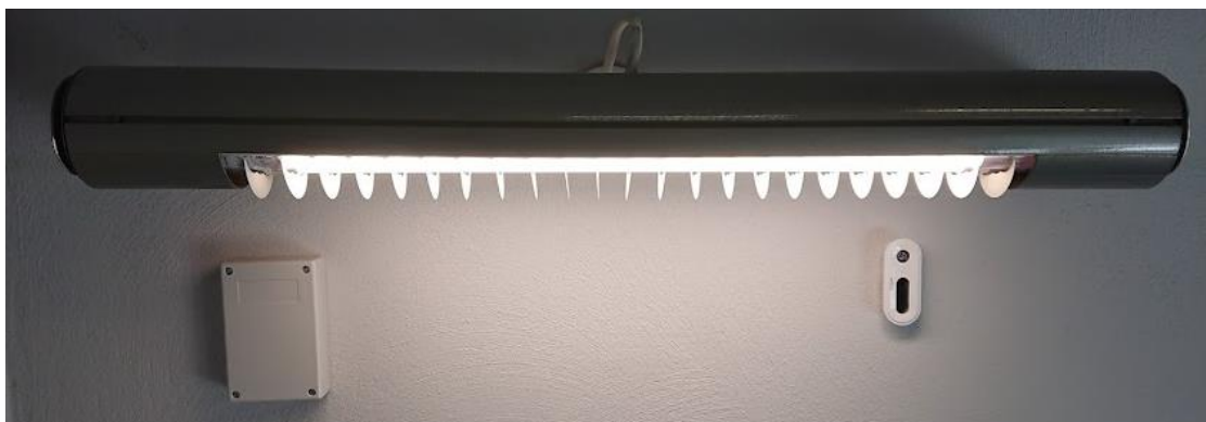
Joonis 2.1 Tesatek mikrolaine liikumisanduri (valge karp) ja EnOcean fotodetektor trepikojas [Autori foto]
