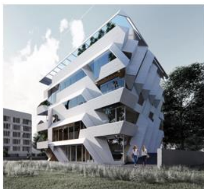
Joonis 2.1 Puitkonstruktsioonil kortermaja Tallinna kesklinnas. PART arhitektibüroo.
