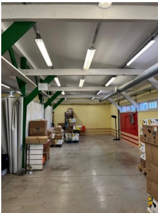
Joonis 3.7 Toiduabi väljastuse valguslahendus, kus kombineerituna on kasutusel luminofoorvalgustid ja leedvalgustid.
