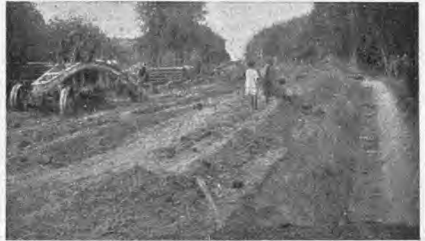
Maanteede kordaseadmine on ka Venemaal tähtsaks küsimuseks. Pildil on näha teehöövel töötamas Novgorodi kubermangus.
