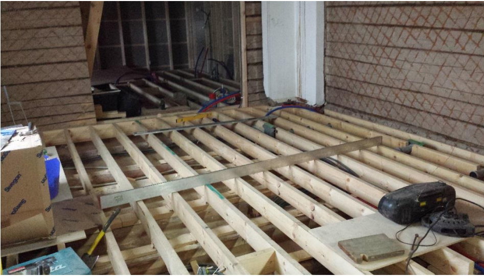
Foto 3. Põrandalaakide paigaldus
