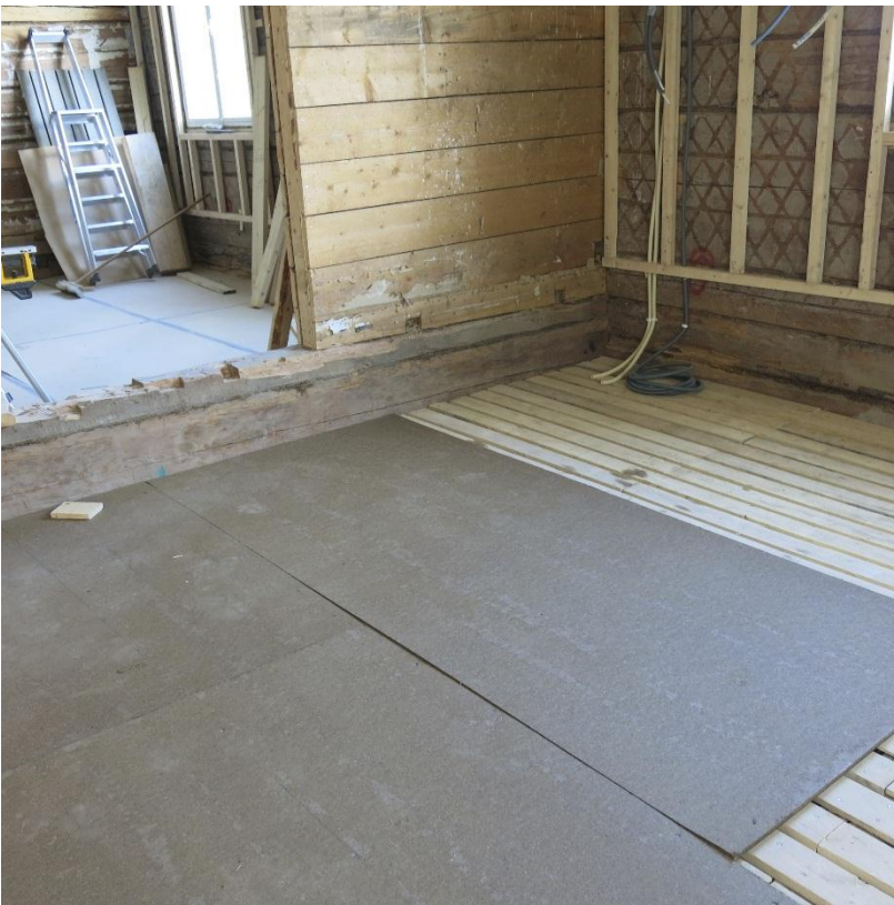
Foto 2. Tuuletõkkeplaadi paigaldamine põrandale
