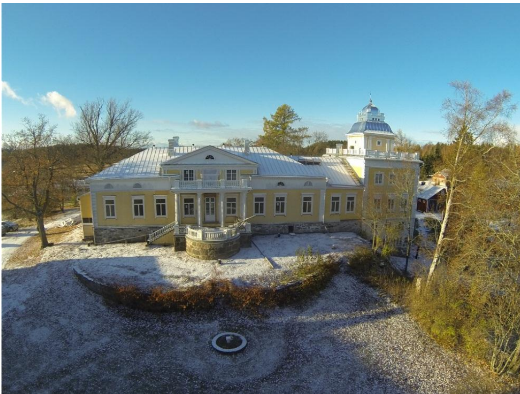
Joonis 3.1. Hoone vaade õhust kirdefassaadile
