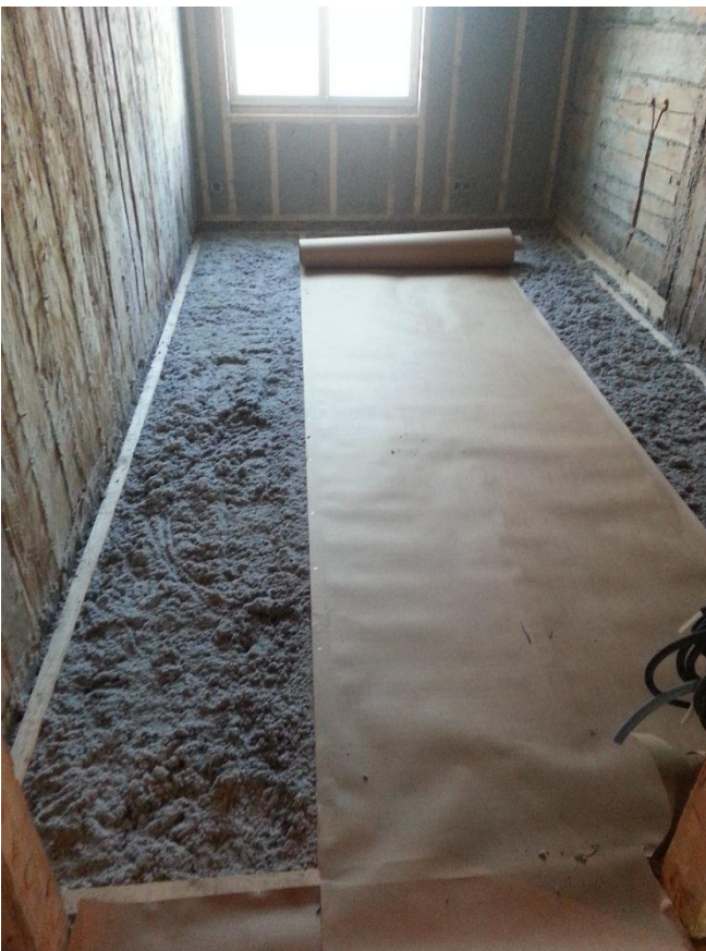
Foto 4. Põrandalaakide vahele paigaldatud puistevill ja aurutõkkepaberi paigaldamine
