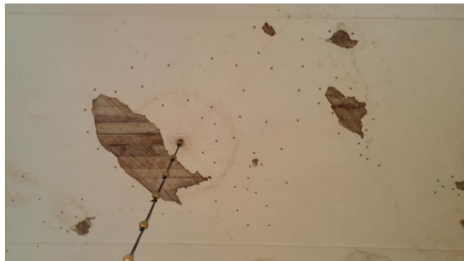
Joonis 1. Pilliroo kasutamine. Vasakul – pilliroost toodetud roomatid ja -plaadid (Klautek OÜ, Saaremaa), paremal – krohvi alt paljastunud roomatid Läänemaal, Karuse kirikus (13. saj).
