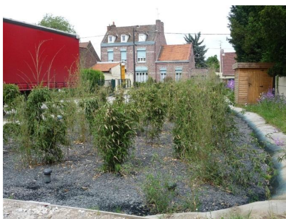
Joonis 2. Makrofüütide (bambus, Phyllostachys viridiglaucescens ) kasutamine trükivärvi sisaldava reovee puhastamiseks paberitööstuse ettevõttes Pocheco (Forest sur Marque, Prantsusmaa)
