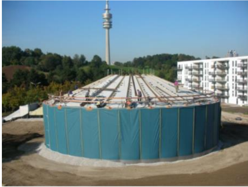
Joonis 4.18. Paak-soojussalvesti ehitamine
