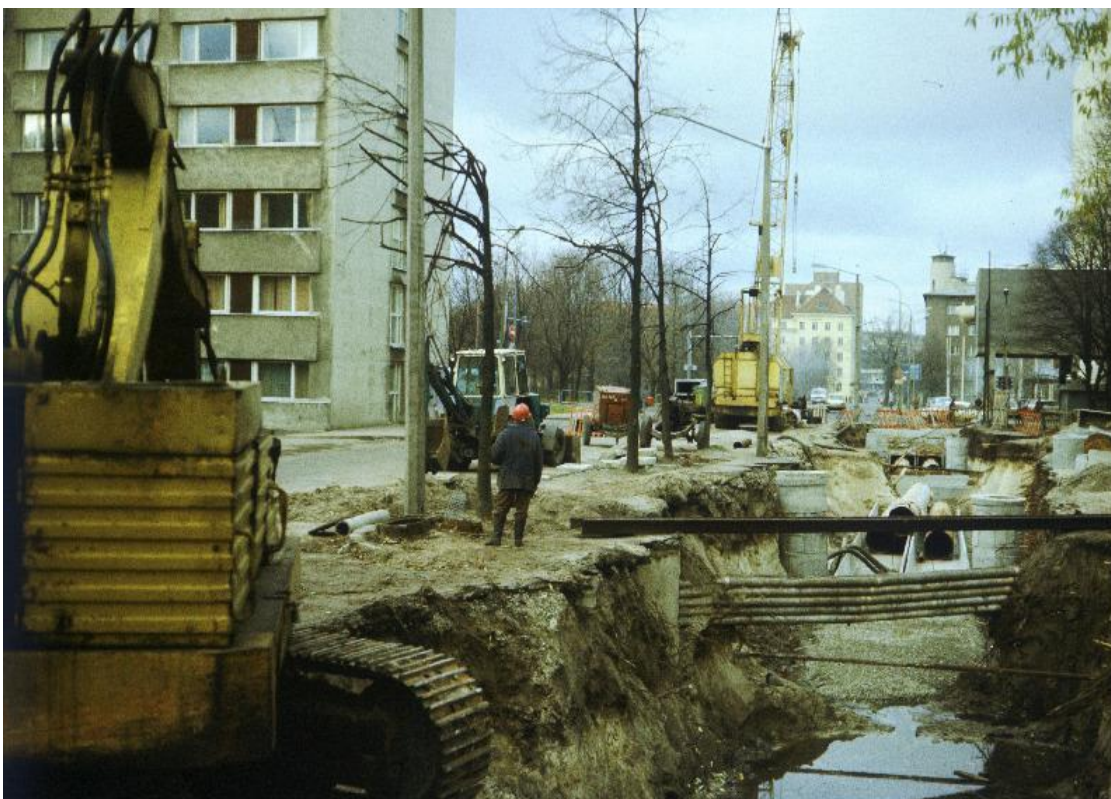
Joonis 1.5. Gonsiori tänava kaugküttetrassi ehitus, november 1990. (allikas: Eesti Rahvusarhiiv. Foto: H. Maasikmets)
