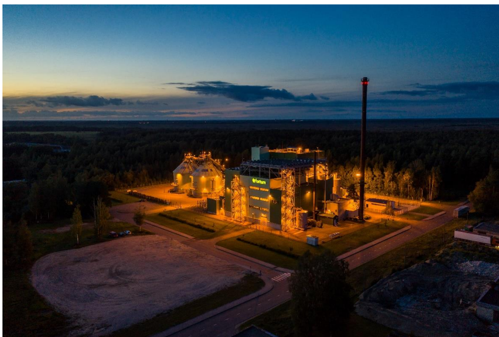
Joonis 1.13. Greni Tartu Elektriyaam (allikas: Fortumi arhiiv)
