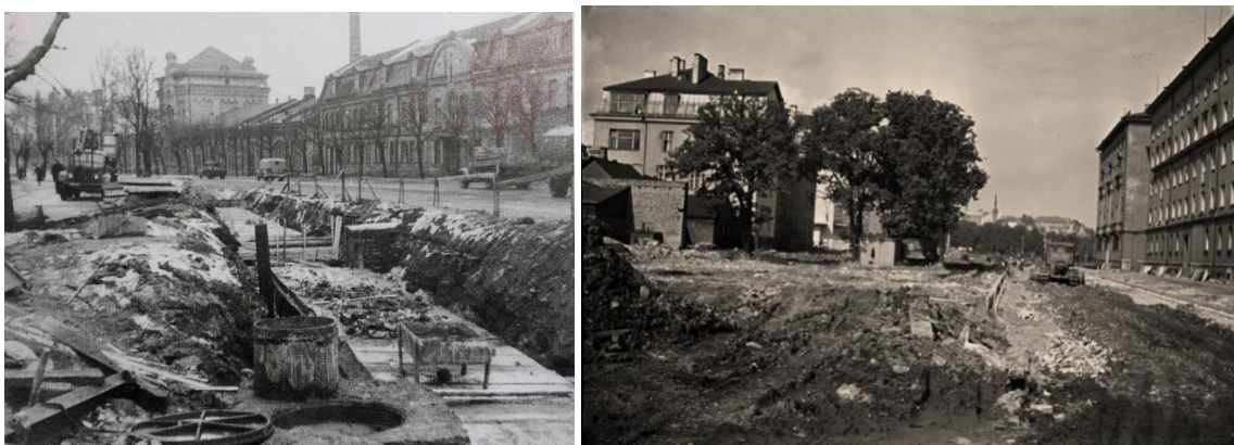
Joonis 1.3. Vasakul – Tallinna esimese soojusmagistraali rajamine Mere puiseteele (1956–1959) (allikas: Utilitase arhiiv); paremal – soojusmagistraali rajamine Lomonossovi (praegu Gonsiori) tänavale (allikas: Tallinna Linnamuuseum, TLM Fn 6582:31)
