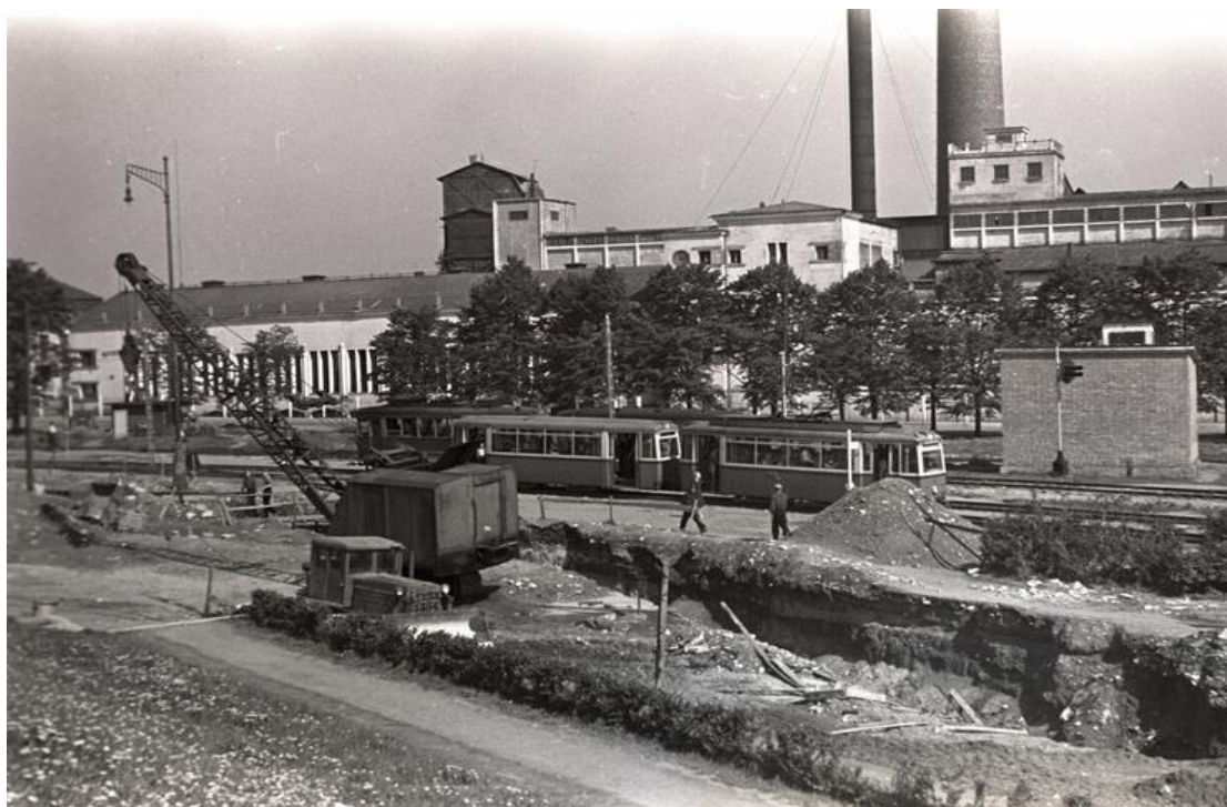
Joonis 1.2. Tallinna soojusvõrkude ehitus tollaegse Tallinna Soojuselektrijaama ees (allikas: Tallinna Linnamuuseum, TLM Fn 2271)
