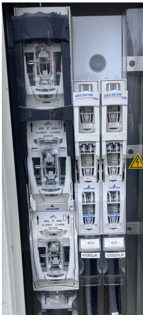
Joonis 2.1 Sularitega jadavinnaklüliti
