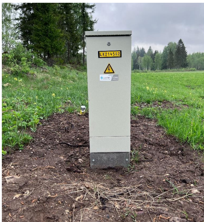
Joonis 2.5 Ühekohaline liitumiskilp
