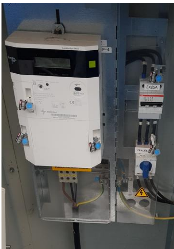
Joonis 2.3 Liitumiskilbi peakaitse koos arvesti ning pealülitiga
