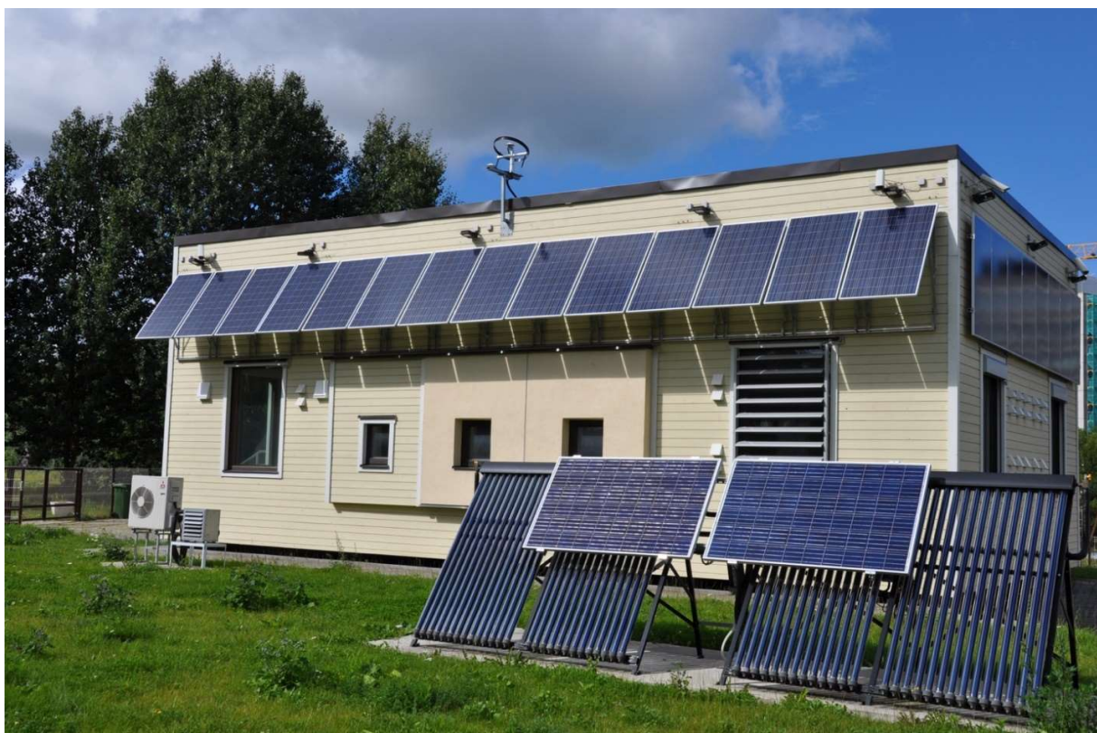
TTÜ Liginullenergia tehnoloogiline testhoone – tuumiktaristu energiatõhususe uuringuteks
