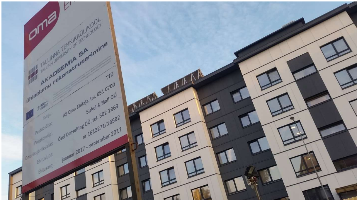
H2020 More-Connect projektis liginullenergiahooneks renoveeritud TTÜ ühiselamu Akadeemia tee 5a.
