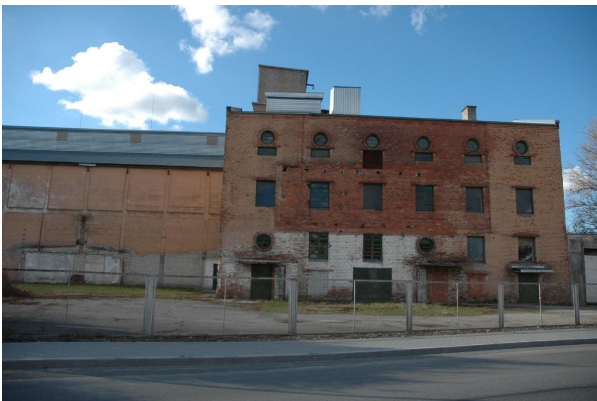
Joonis 14. Jaama 1 krundil asuva hoone tänavapoolne fassaad
