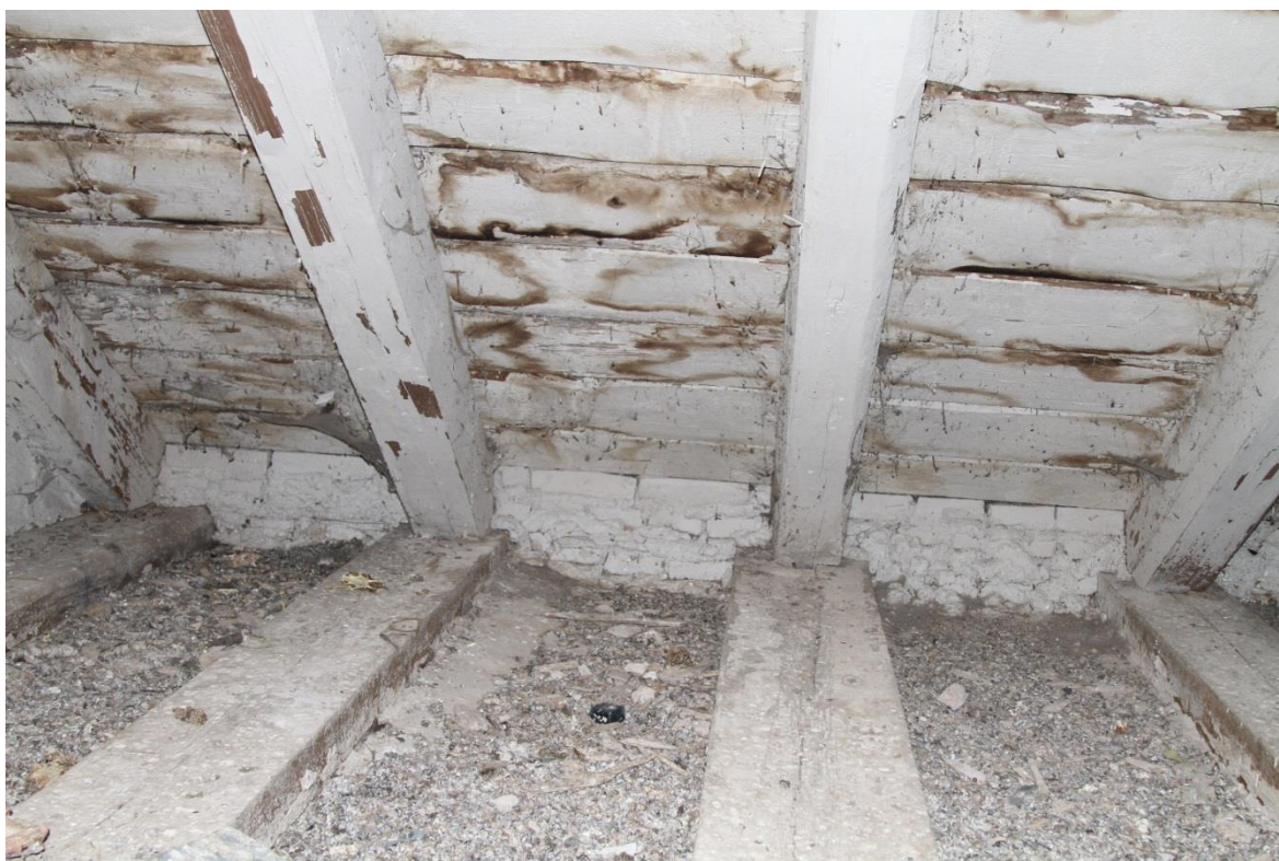
Foto 7. Ilma räästatõstjateta algupärane lahendus. Räästas on hiljem silikaattelistega kinni müüritud.
