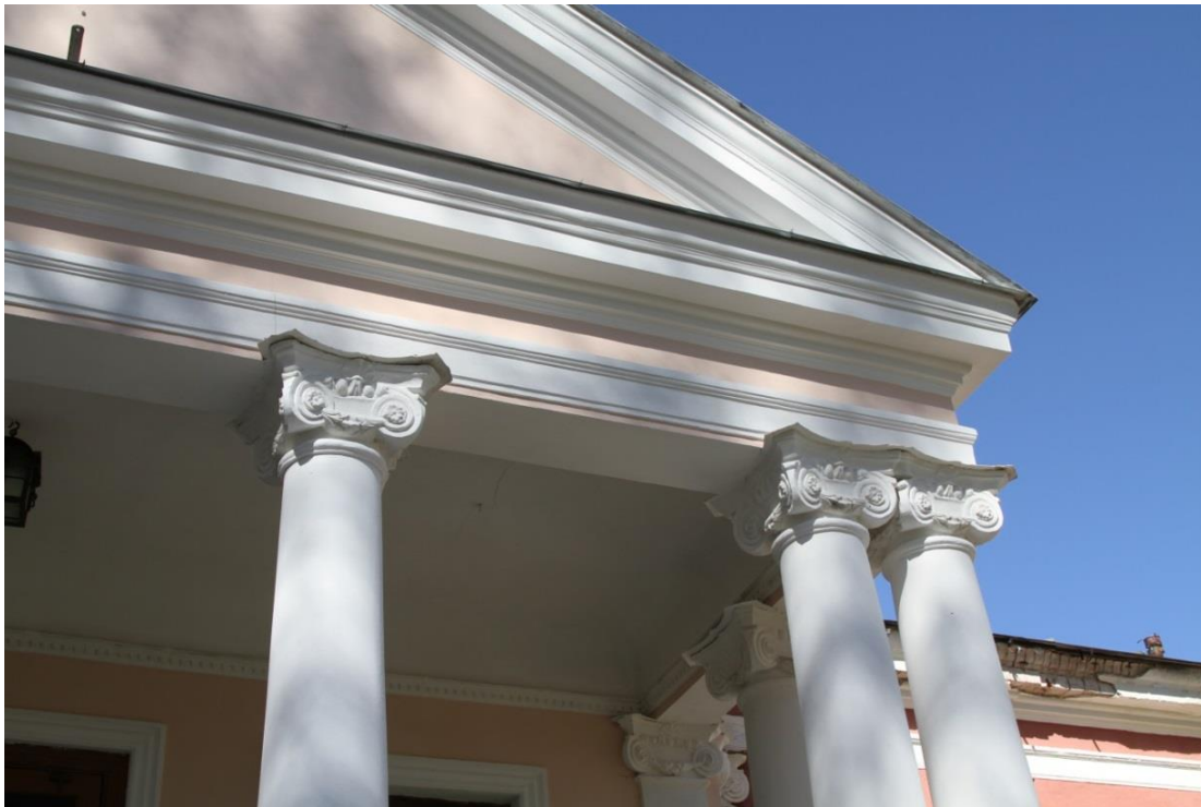
Foto 23. Peasissekäigu kohal olev restaureeritud kolmnurkfrontoon.
