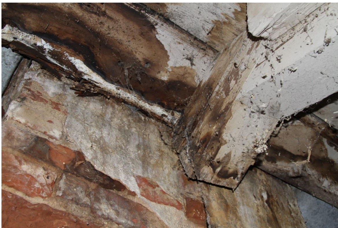
Foto 12. Näide läbijooksust tingitud harjalaudise ja lõigatud sarika niiskuskahjustustest korstna ümbruses.
