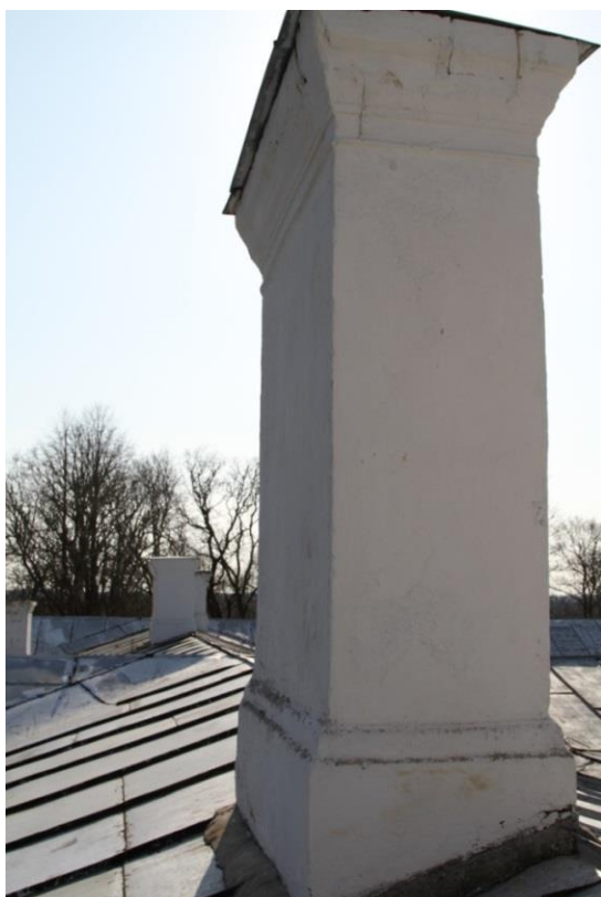
Foto 20. Katteplekiga korstnaotsad on säilinud tunduvalt paremini.
