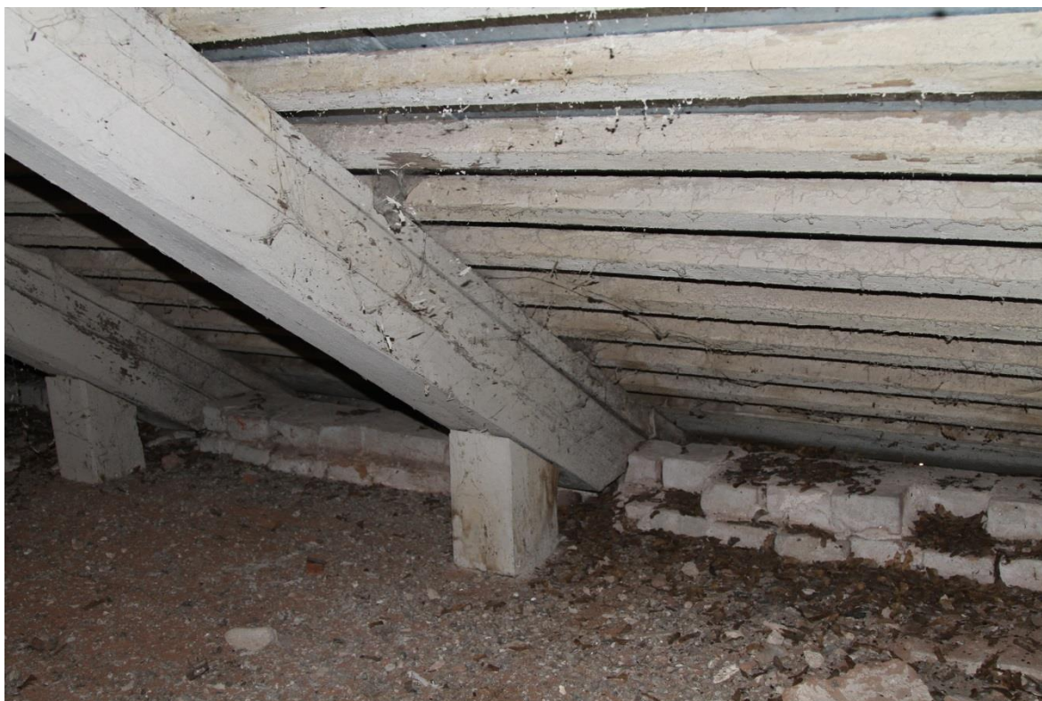
Foto 8. Kolmanda ehitusjärgu sarikate toestamise lahendus. Räästas pole nii ulatuslikult kinni müüritud, kui varasema ehitusjärgu osas.
