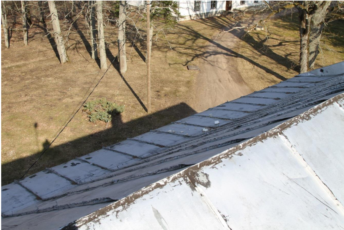
Foto 16. Vaade katuse osale, mida pole räästast tõstetud ning omab algupärast murtud kuju.
