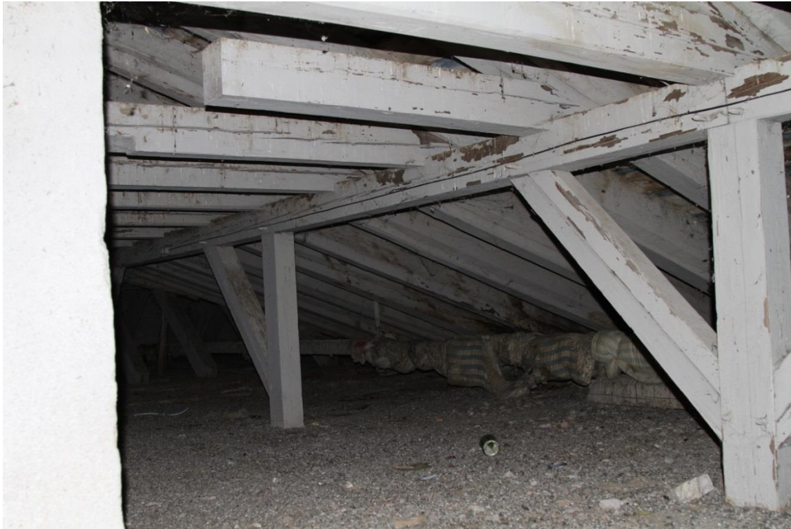
Foto 1. Pärlinkonstruksioon hoone keskosas ühe ja kahe kaldtoega postidel. Näha on ka lõigatud penni.
