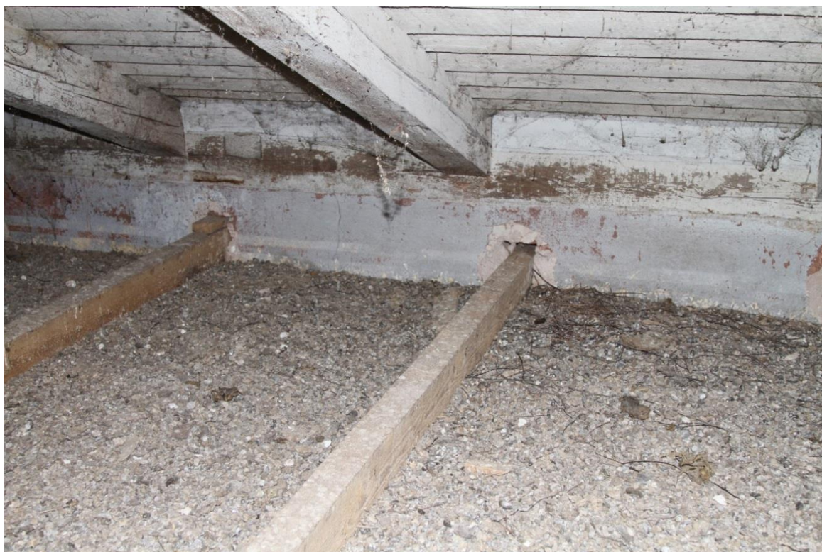
Foto 9. Prussile toetuvad ja seinä betoneeritud sarikad talveaia osas.
