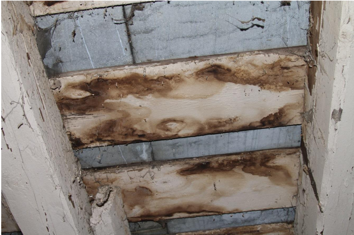
Foto 13. Näide pruunikate niiskujälgedega roovlaudisest.
