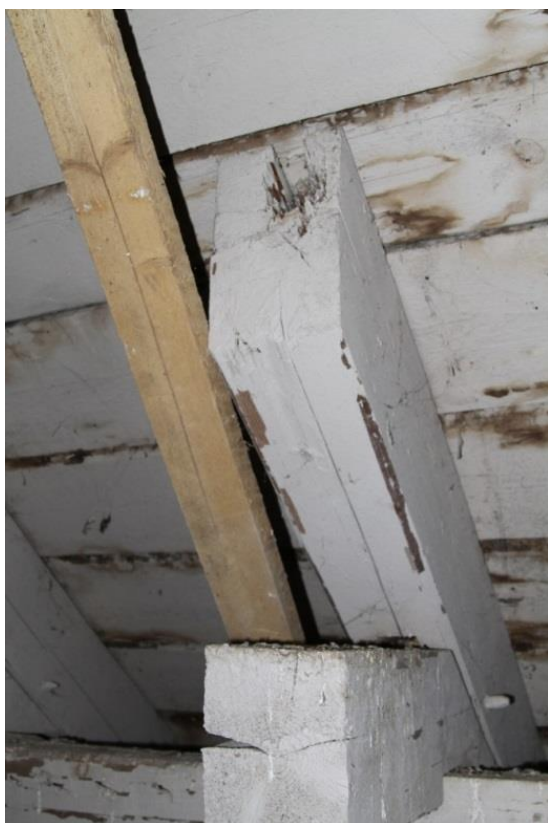
Foto 6. Lõigatud sarikas ja penn ning neid asendav pruss.
