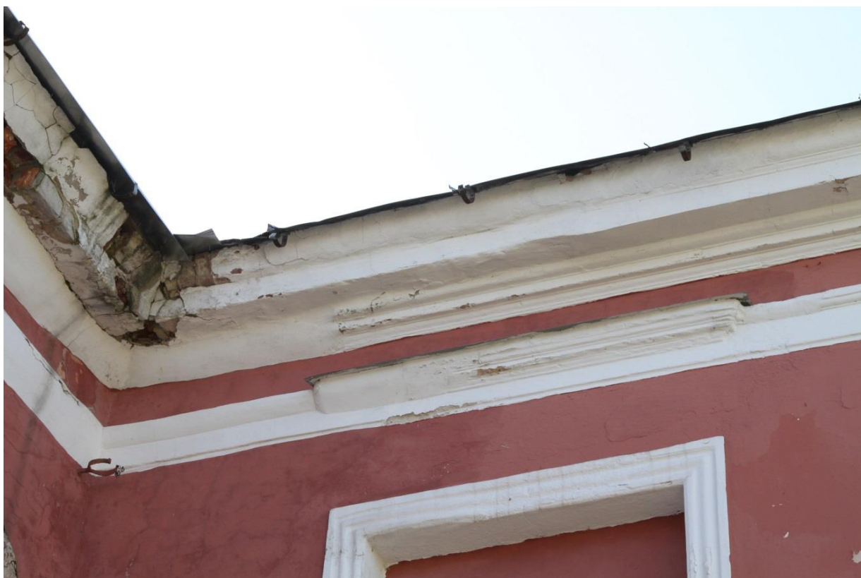
Foto 26. Näide krohviparandustest, kus pole järgitud karniisi esialgset profiili.
