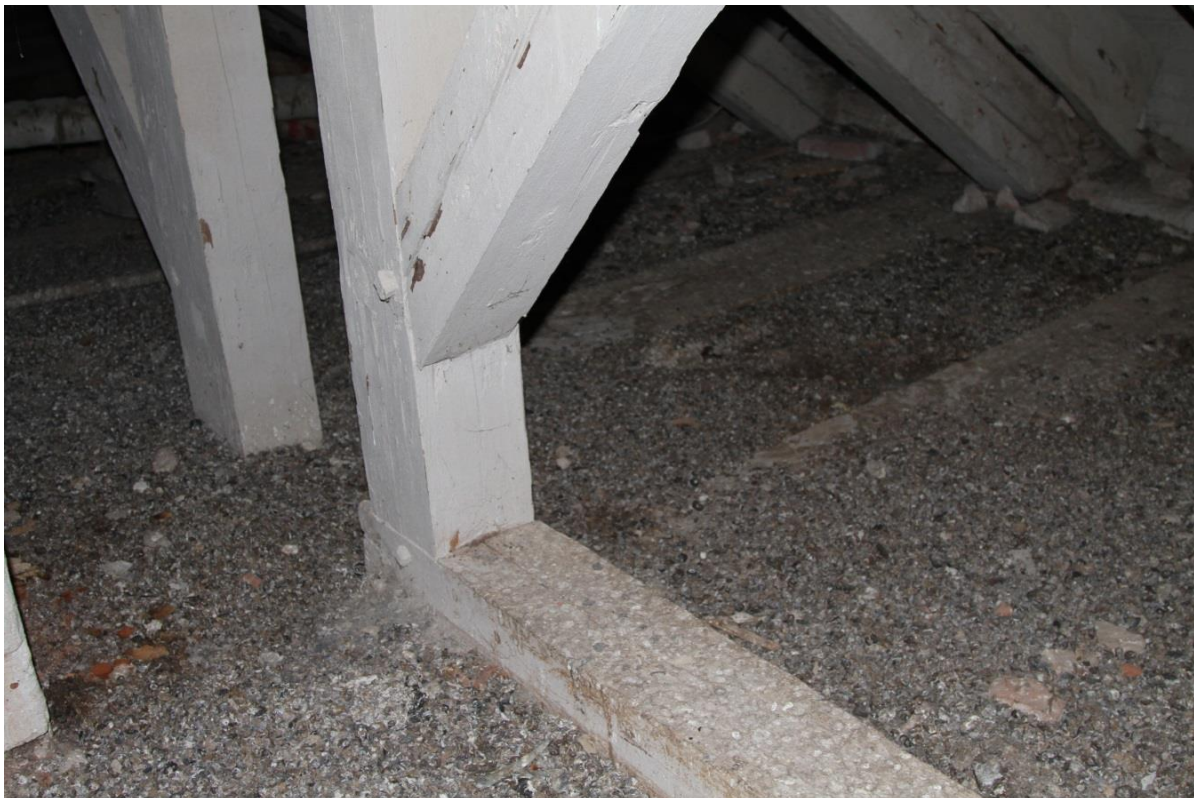
Foto 2. Võrdluses esialgne ja hilisem lahendus. Viimase korral on post toetatud aluspuule.
