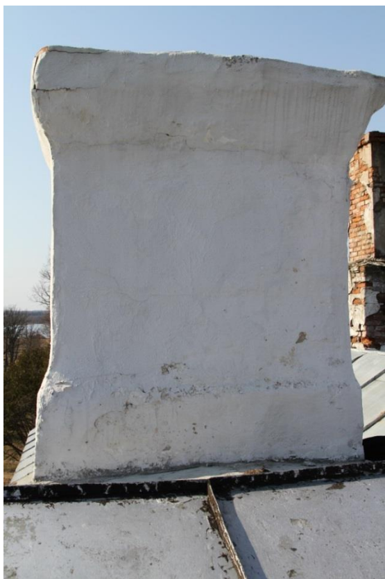
Foto 21. Hooletult krohvitud korstnaotsad on kaotanud profileeringu.
