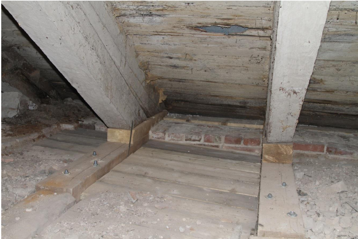
Foto 10. Vahelae talade jätkamine. Ühendus on teostatud poltliite ja kobade abil.
