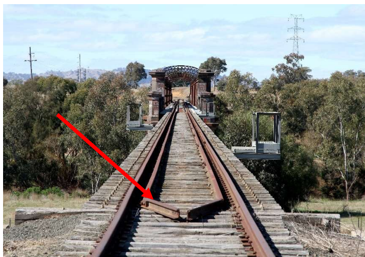
Joonis 3.3 Kontaktnurgikud Lachlani jõge ületaval raudteesillal [10]
