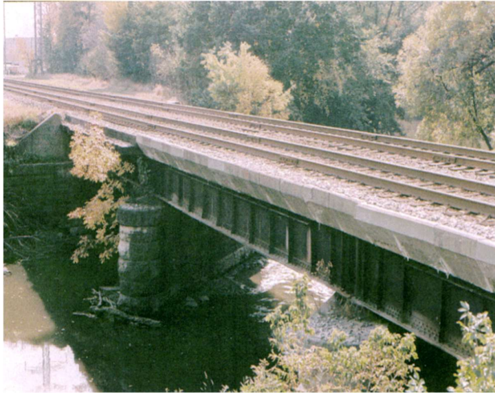
Joonis 3.2 Kinnise tekiplaadi struktuuriga raudteesild [9]
