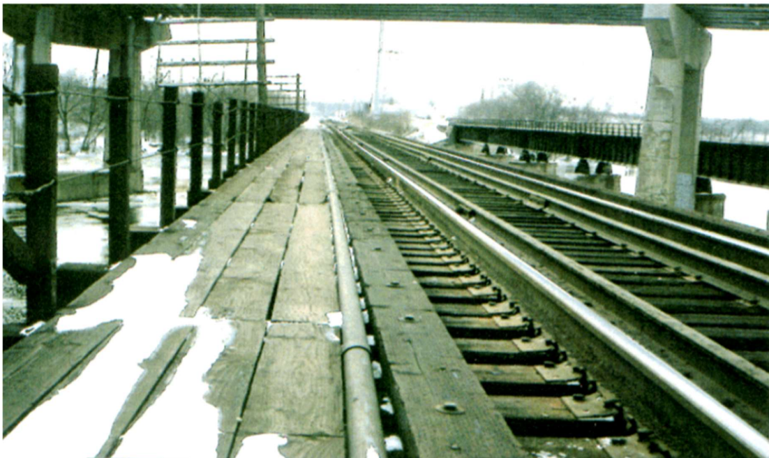
Joonis 3.1 Avatud tekiplaadiga raudteesild [8]
