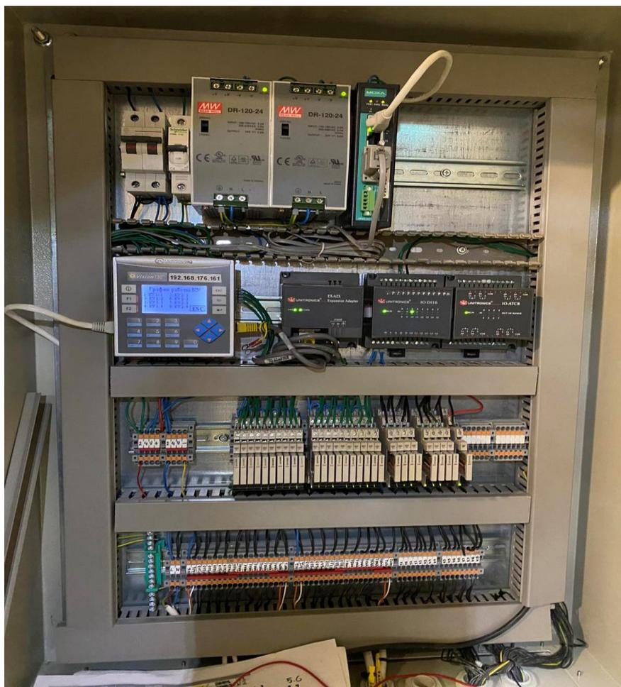
Рис. 2.11 Щит управления конденсаторными установками в подземной подстанции «Иллука» на шахте «Эстония»
