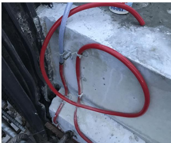
Foto 1.2.4.2: Töövuuki paigaldatud injekteerimisvoolik [34]
