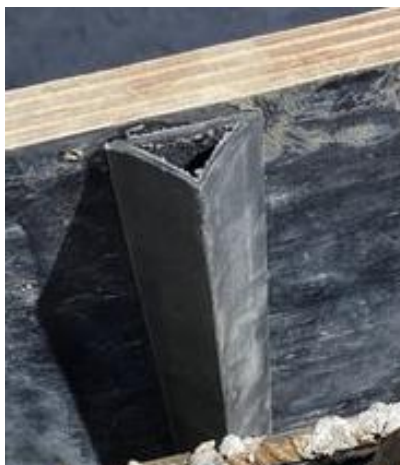
Foto 2.1.2.1: Raketise seinale paigaldatud kolmnurkliist praotekitajana [autori erakogu]
