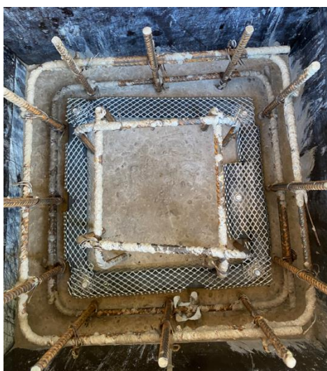
Foto 2.2.1.7: Katsekeha 10 vuugilindi paigaldus [autori erakogu]
