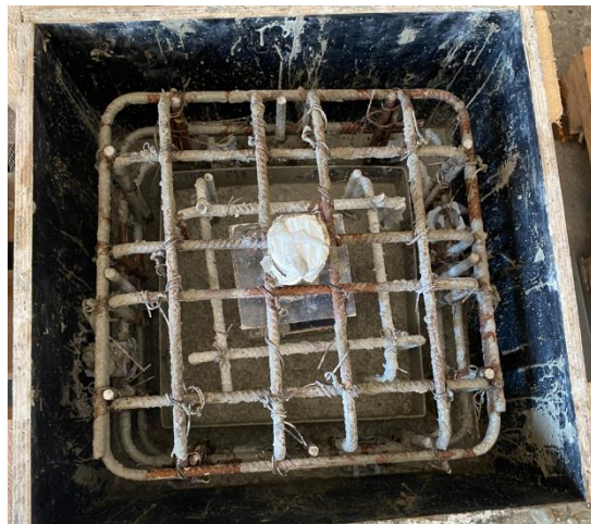
Foto 2.2.2.3: Katsekeha 4 enne seinte/lae betoneerimist [autori erakogu]
