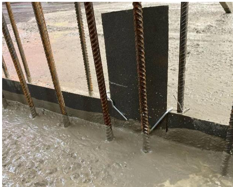
Foto 1.2.1.2: Põranda ja seina liitekohta paigaldatud polümeerse kattega metallist töovuugiprofiil [23]
