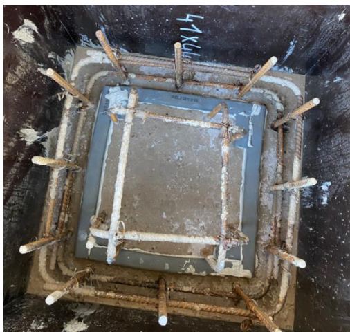
Foto 2.2.1.5: Katsekeha 8 vuugilindi paigaldus [autori erakogu]
