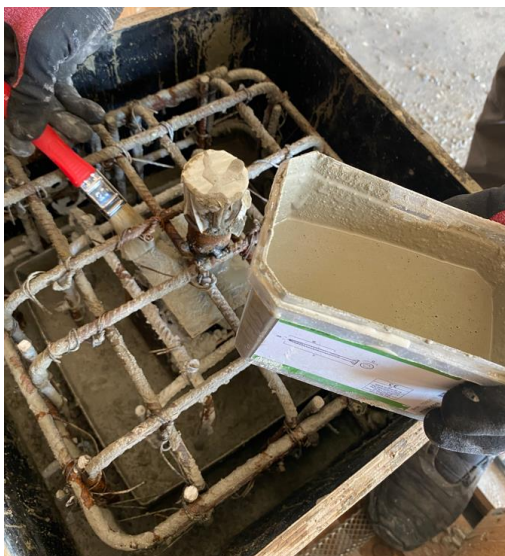
Foto 2.2.2.1: Katsekeha 6 metallplaadi katmine nakkesebuga [autori erakogu]
