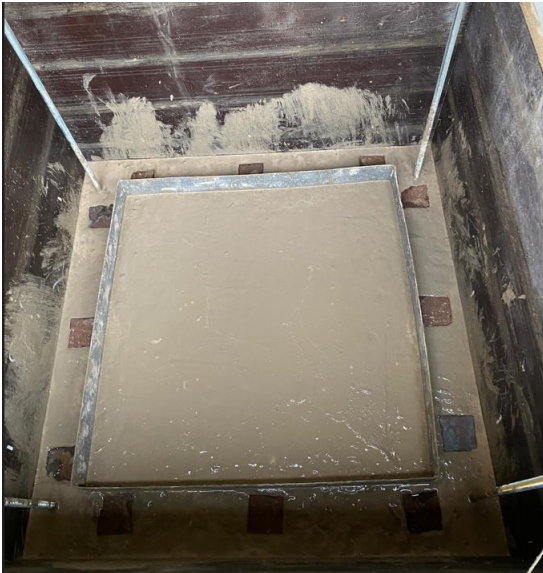
Foto 2.2.2.7: Katsekeha 11 põhjaplaat peale betoneerimist [autori erakogu]
