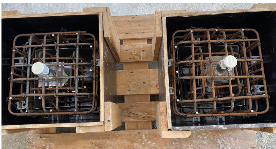
Foto 2.2.1.3: Katsekehad 1 ja 2 valmis betoneerimiseks [autori erakogu]
