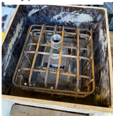
Foto 2.2.1.6: Katsekeha 10 valmis betoneerimiseks [autori erakogu]
