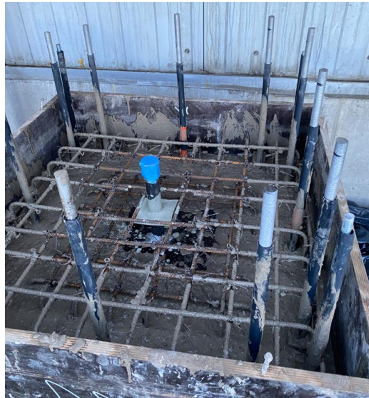
Foto 2.2.2.6: Katsekeha 11 seinte/lae betoneerimine [autori erakogu]
