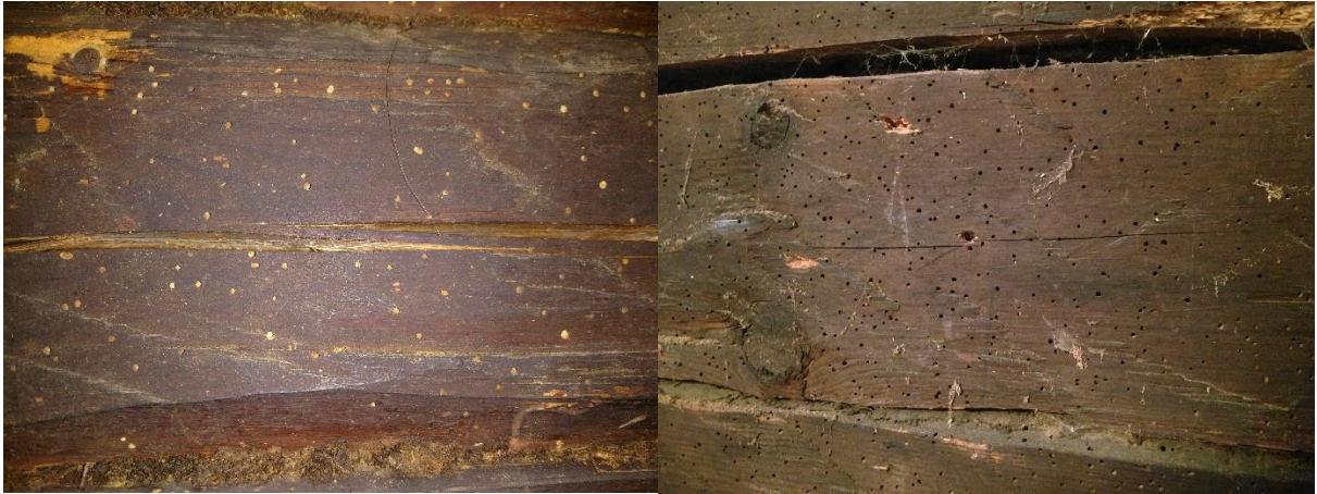
Joonis 12. Väljalennuavad palgis
