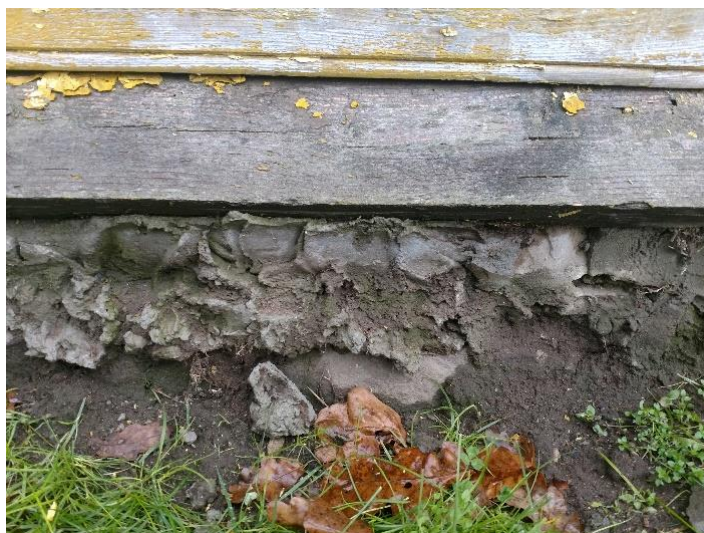
Joonis 8. Seguga lapitud sokkel
