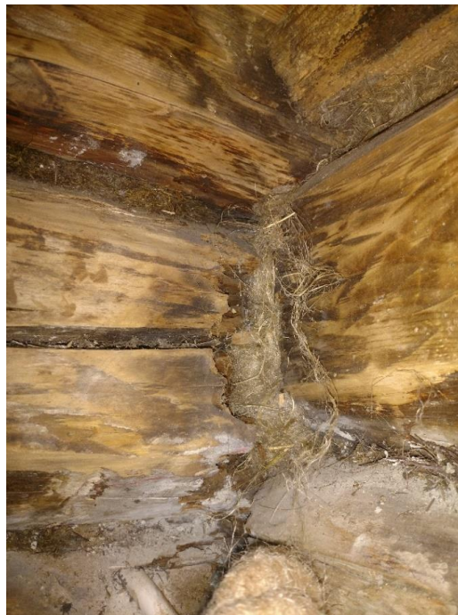
Joonis 13. Niiskukahjustus palkide ühenduskohas
