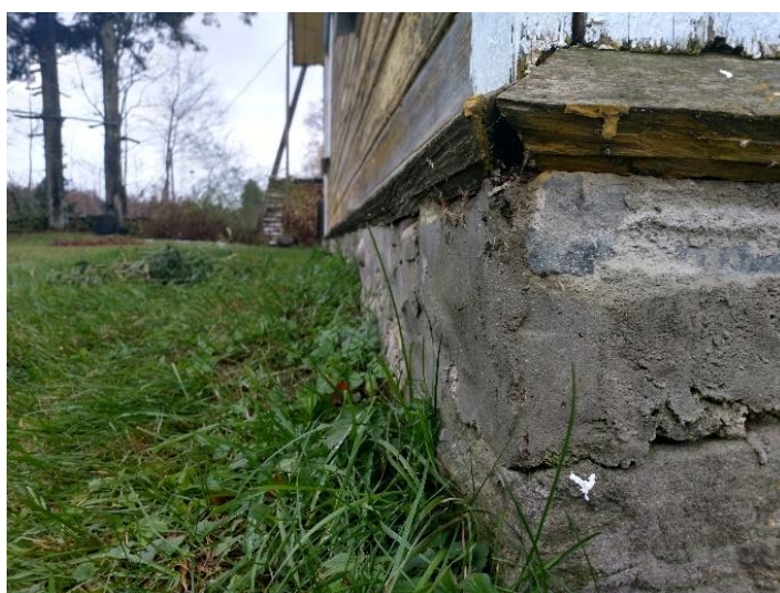
Joonis 9. Veelaud ei ole piisavalt üle sokli ääre
