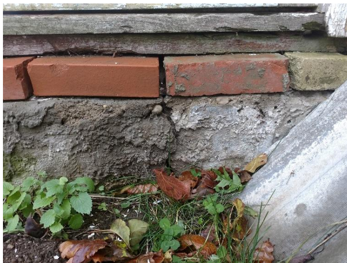
Joonis 10. Vertikaalne pragu soklis
