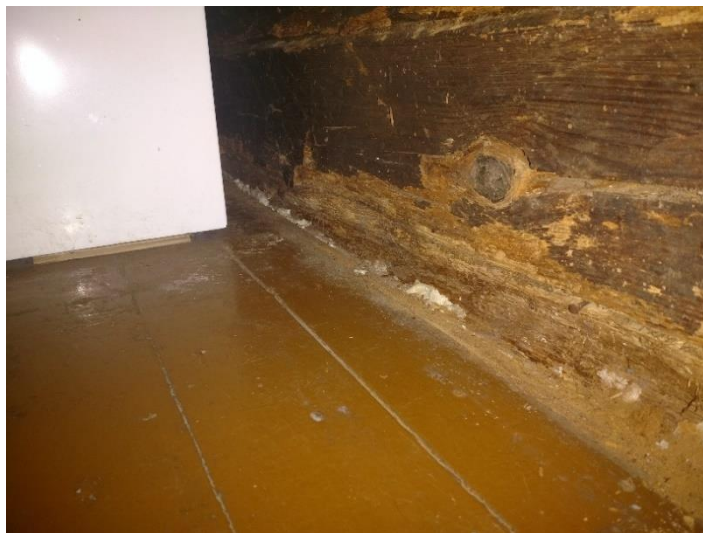
Joonis 14. Putukate ja näriliste poolt kahjustatud palk
