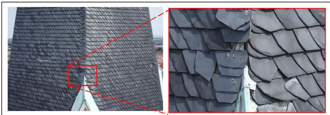
Joonis 1.10 Aerofoto Halberstadt katedraali tornist ja sissesuunitud väljavõte katusel esinevast kahjustusest [15]
