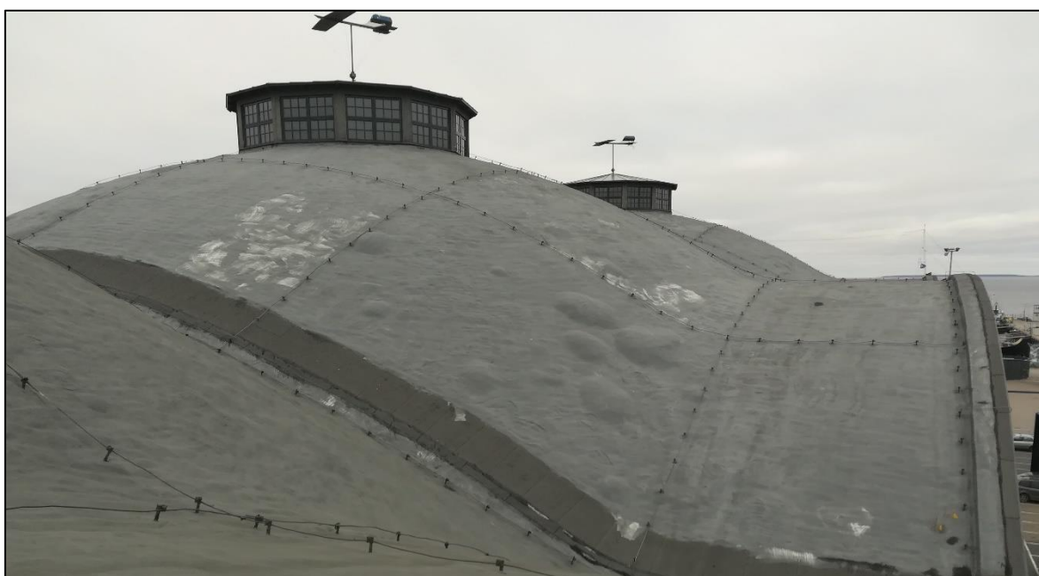
Joonis 7.16 Tallinna Lennusadama katusekatte deformatsioonid
