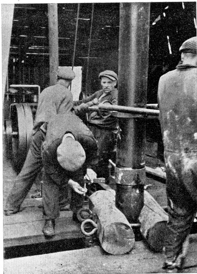
Joon. 12. Näide suurema puurkaevu ehitamisest: mantel-toru puurauku sissekeeramine.
