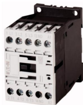
Рисунок 2.11. Магнитный пускатель [9]
